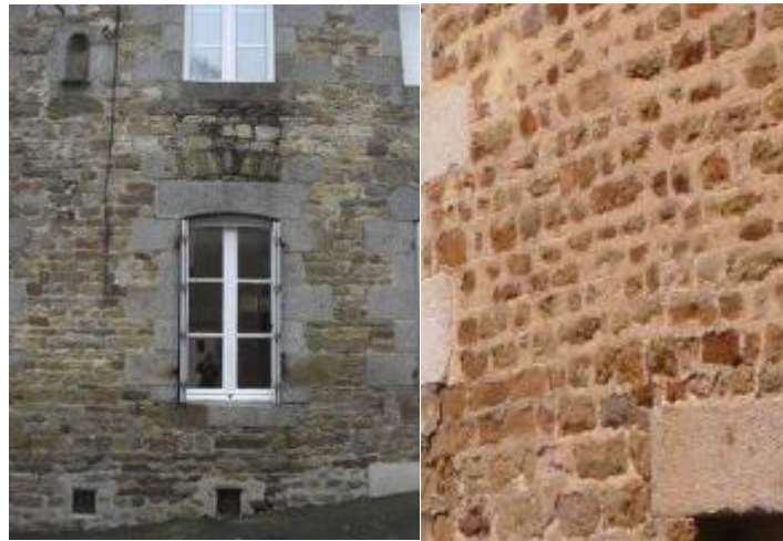
Le granite gris de Saint-Michel-de-Montjoie et une structure en moellons (source : diagnostic SPR Villedieu-les-Poêles)
