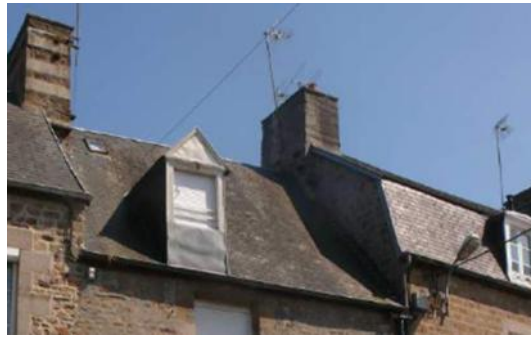
Toiture en ardoise (source : diagnostic SPR Villedieu-les-Poêles)
