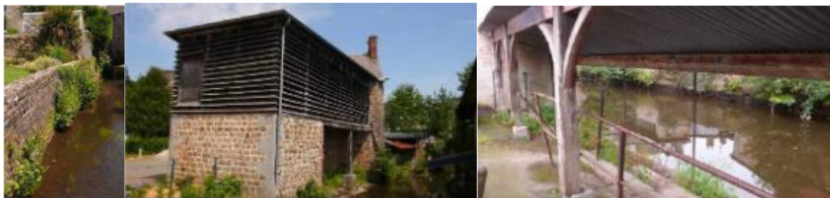
Berge maçonnée, ancien séchoir visible au-dessus de bâtiments, lavoir (source : diagnostic SPR Villedieu-les-Poêles)
