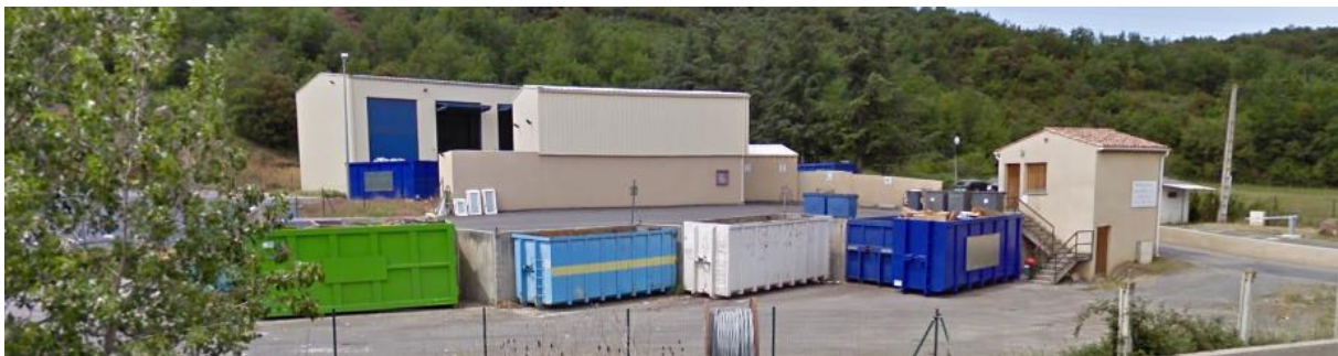
Centre de transfert et déchetterie de Quillan.
