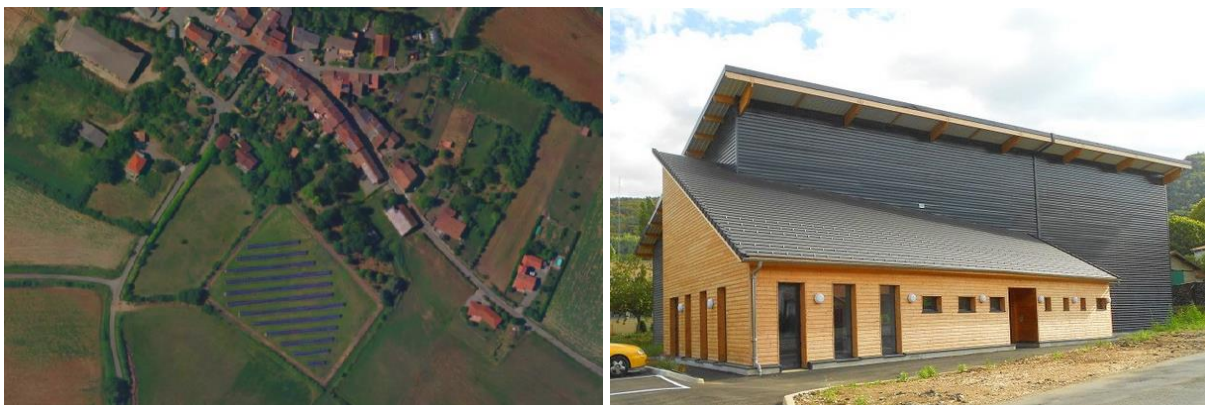
Parc photovoltaïque au sud du village de Trézières (à gauche) et salle d'escalade de Belcaire accueillant des panneaux solaires sur la toiture (à droite).
