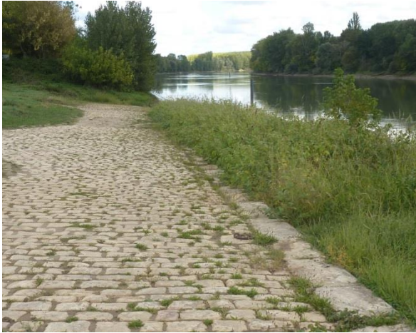
Le port et ses aménagements, un espace à valoriser et des aménagements à restaurer : cale et pavements...
