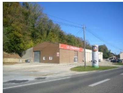
Une faible qualité urbaine qui déprécie les entrées de ville
