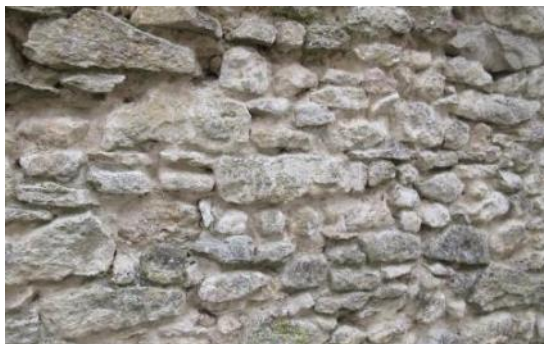
Moellon hourdé au mortier, sans enduit de finition (Hure).
