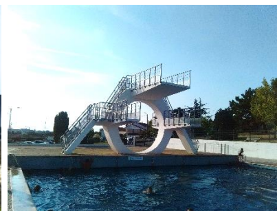
Piscine municipale de la Réole
