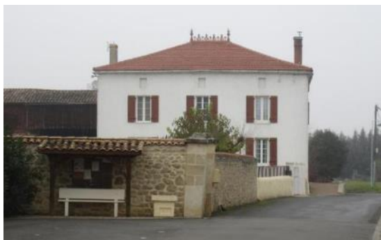
Maison à bâtiment d'activité latéral (Bourdelles)
