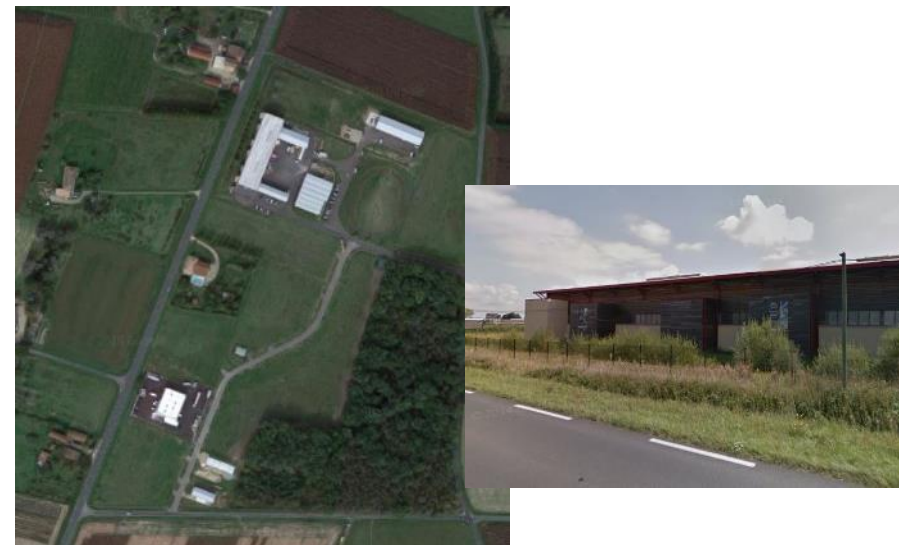
Ecopôle de Loupiac-de-la-Réole : Apport du végétal en bordure de voie et bardage bois
