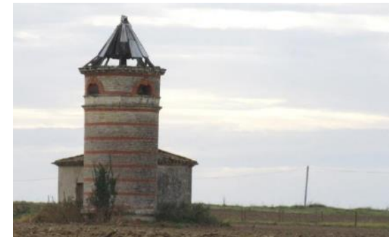
Château d'eau d'architecture qualitative (Gironde sur Dropt)
