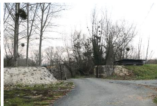
Digue et système de fermeture au niveau de la route
