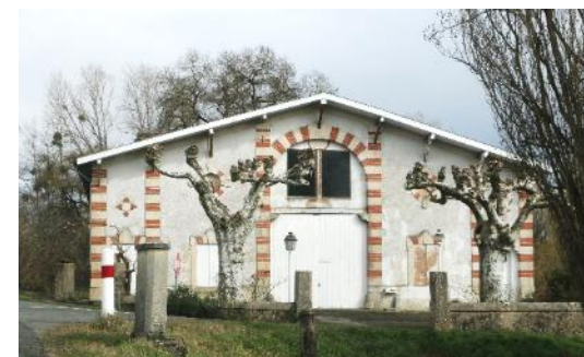
Hangar ancien utilisant la tuile en ornements, implanté le long de la RD15
