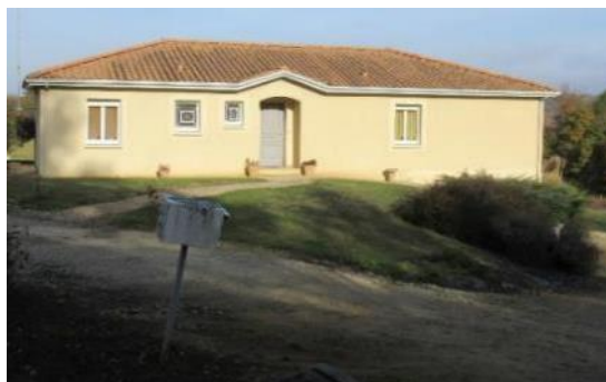
Maison de constructeur, typologie provençale (Brouqueyran)
