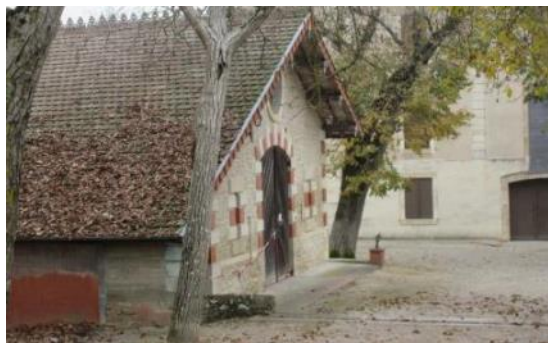
Tuile mécanique et crête de faîtage festonnée, partie intégrante de l'architecture (Fontet)
