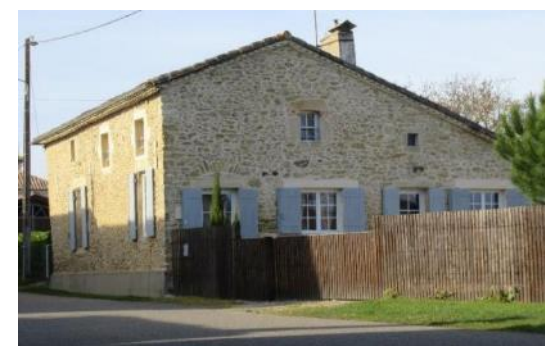
Façade principale en pignon (Brouqueyran).
