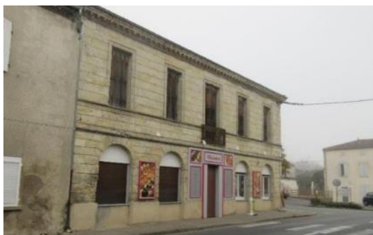
Maison à commerce en rez-de-chaussée (Mongauzy)
