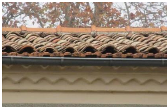
Tuile canal sur génoise. Doubles en tuile mécanique
