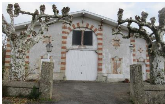
Bâtiment agricole d'activité multiple, pouvant comporter une habitation (Bagas)
