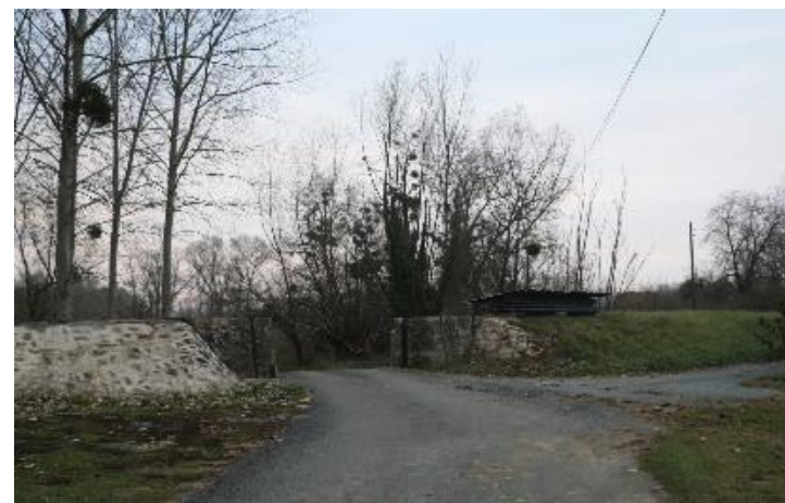
Digue de la vallée de la Garonne
