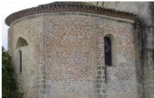
Maçonnerie en moellon prolongée en brique foraine épaisse (chevet de l'église de Bagas)
