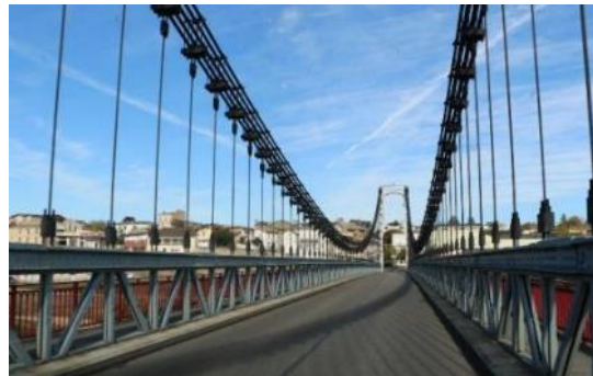
Grand pont métallique de la Réole
