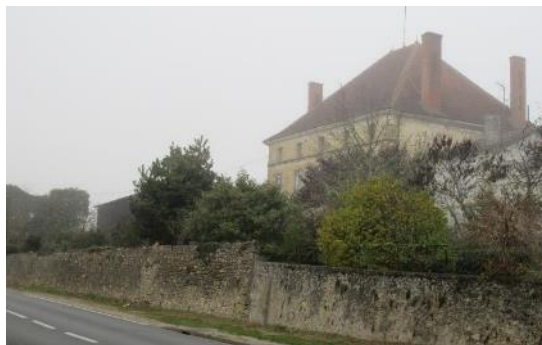
Château massé disposant d'une grande terrasse et d'un terrain arboré (Mongauzy)
