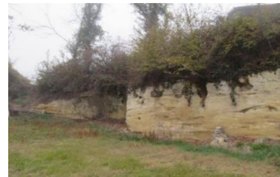
Ancienne carrière dans un banc de calcaire (Saint Michel de Lapujade)
