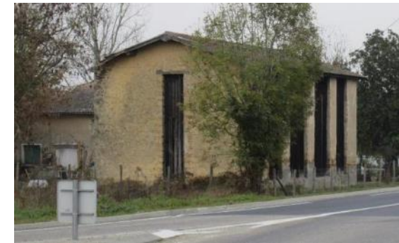
Séchoir en maçonnerie (Aillas)
