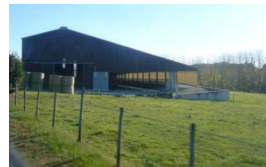
Bâtiment agricole intégré (Saint Laurent de Plan).
