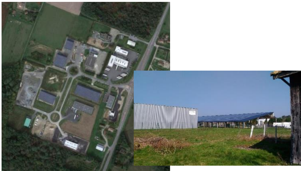
Zone du Bois Majou Nord à Aillas: une mutualisation entre construction et production d'énergie
