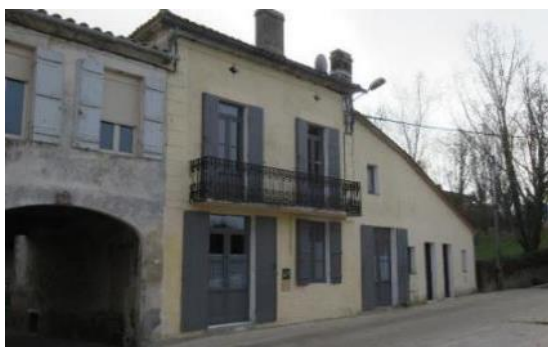
Respect des modénatures, enduits et menuiseries soignées (Aillas)
