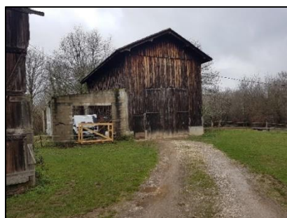
Séchoir pour transformation en habitat (Pondaurat)
