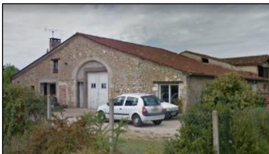
Extension de l'habitation à tout ou partie de la « coucoute » (Loupiac-de-la-Réole)
