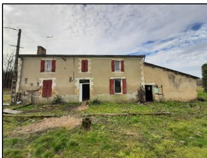
Extension de l'habitation existante sur l'annexe à droite (Auros)
