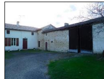
Extension de l'habitation existante au niveau de la grange à droite (Berthez)
