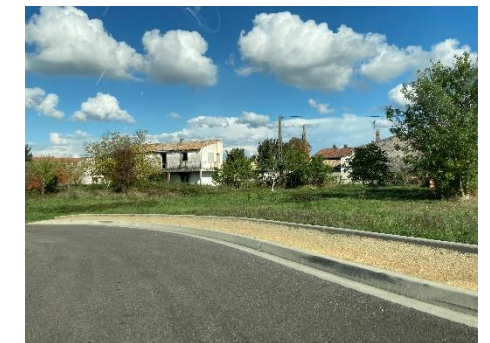
Vue sur une construction en mauvais état côté école
