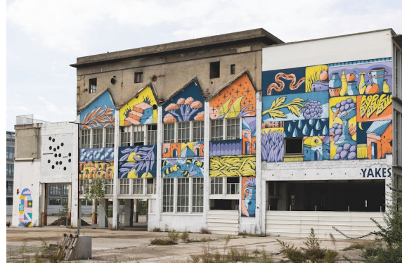
La halle nord, vestige du passé industriel conservé © Tom Augendre
