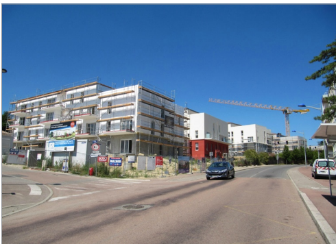
Le bas du Razat en construction - ©Agence d'urbanisme
