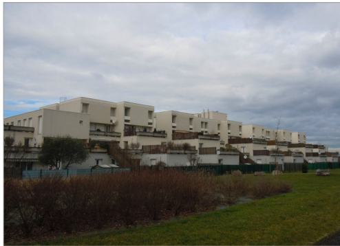
Le Carreau-habitat intermédiaire © Agence d'urbanisme Lyon
