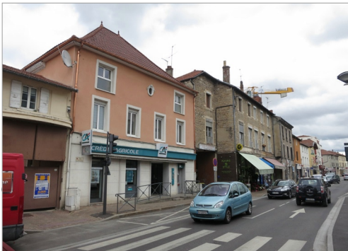
Centre-ville - rue de la République
