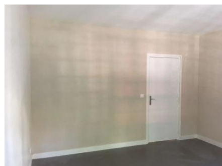
Enduit terre crue sur cloison en panneaux terre/chaux/chanvre © Terramano – Paris Habitat (Paris)
