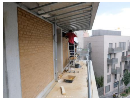
Enduit terre crue sur cloison en panneaux terre/chaux/chanvre © Terramano – Paris Habitat (Paris)
