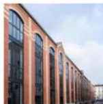
Ancienne usine Gutel au Pré-Saint-Gervais
