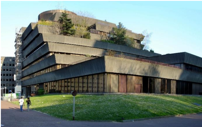
Préfecture de la Seine-Saint-Denis à Bobigny
