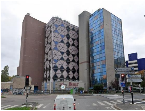
Ancien immeuble France Télécom à Bagnolet
