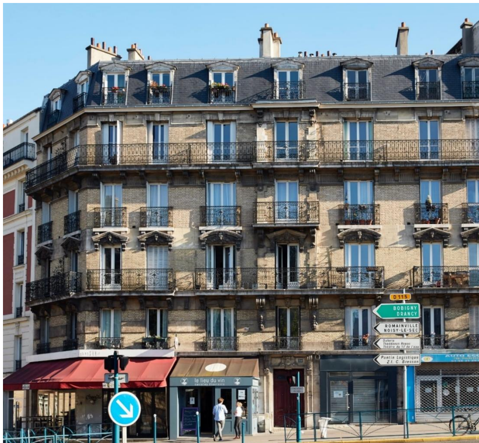
Avenue du Général Leclerc à Pantin
