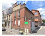
Atelier rue Méhul à Pantin
