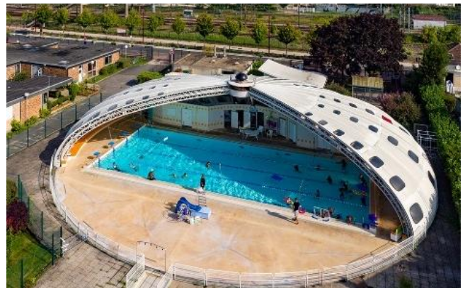
Piscine Tournesol à Bondy
