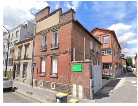
Atelier rue Méhul à Pantin
