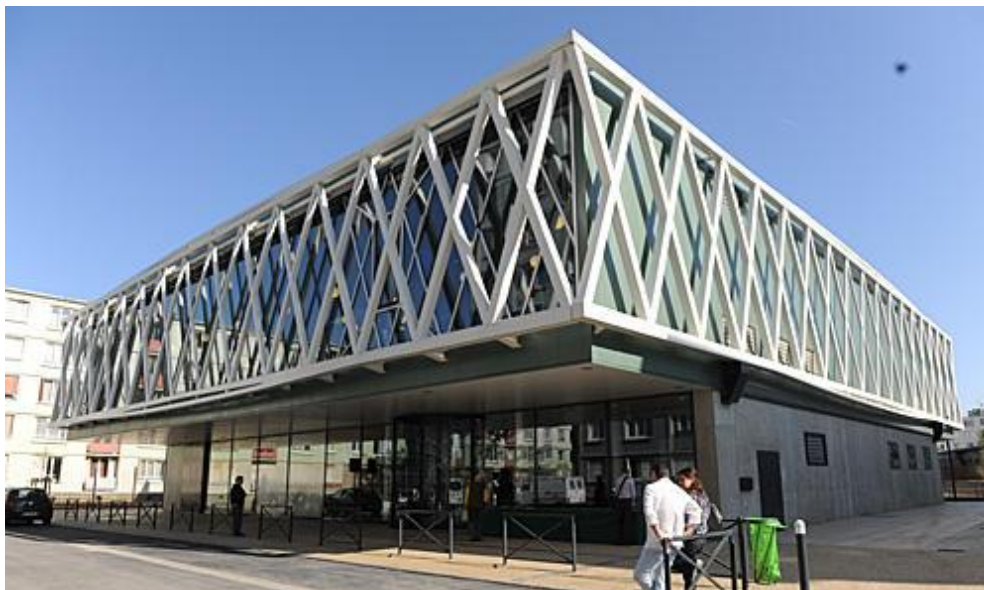
Médiathèque de Romainville
