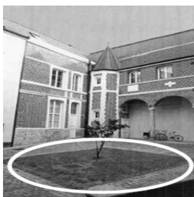
Puits d'infiltration (Source : ADOPTA)
