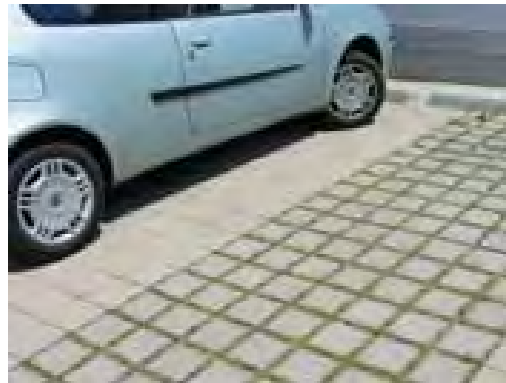
Pavés non jointifs (Source : www.crit.archi.fr )
