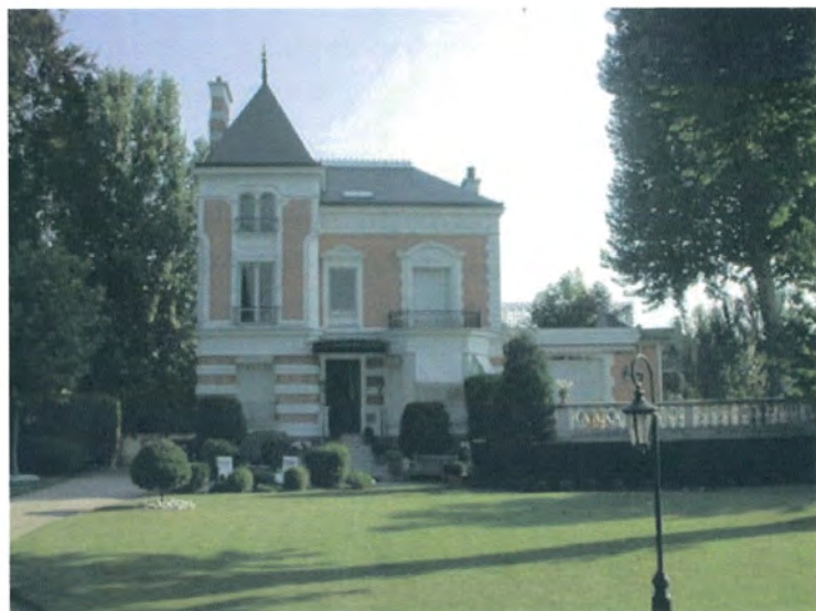
7, Avenue de Chennevières
