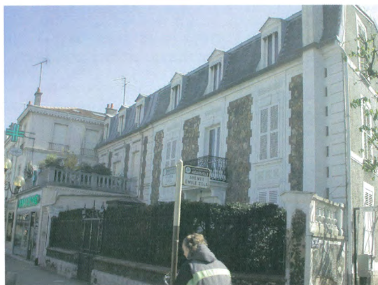
Exemple de toit Mansard
