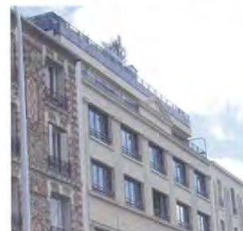
Retrait des étages supérieurs par rapport à la façade et traitement contemporain
