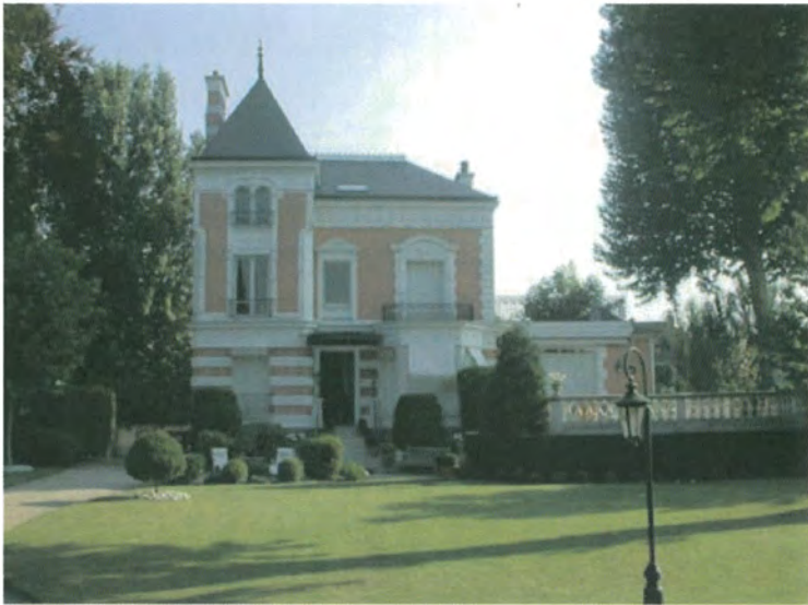
7, Avenue de Chennevières
