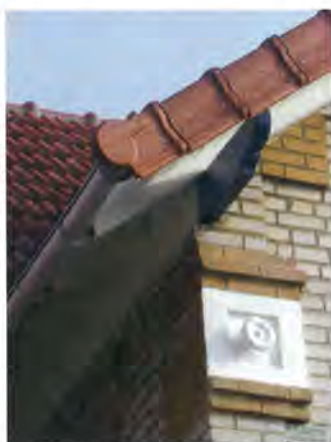
Détail de débord de toiture, avec charpente apparente, sur un pavillon des années 20
