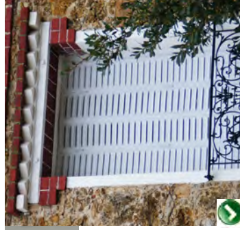
BONNE PRATIQUE : Intégration du coffre de volet roulant en retrait habillé par un lambrequin en bois peint.
