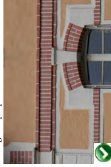
TRAVAUX INADAPTÉS : Mise en peinture des parements briques. Utilisation de couleurs, de motifs ou de bardage inappropriés.
