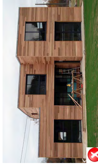
Mauvaise pratique : Façade lisse sans modénatures, sans reliefs, bardage posé à l'horizontal qui accentue l'effet «boîte».
