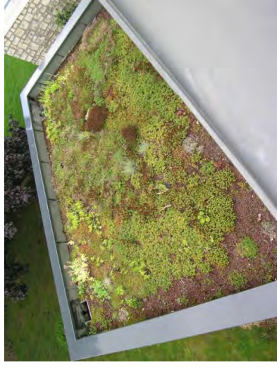
Toiture végétalisée de type extensif.
