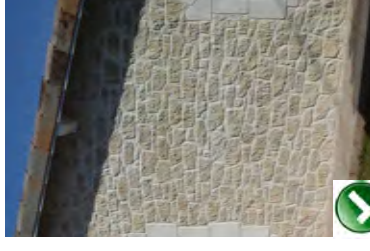
Mur sain : Végétalisation possible
