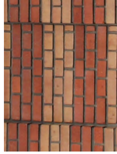
Parement de briques argileuses
