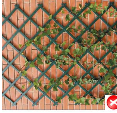
Mauvaise pratique : Treillage PVC à proscrire. Système collé au mur sans espace de ventilation.
