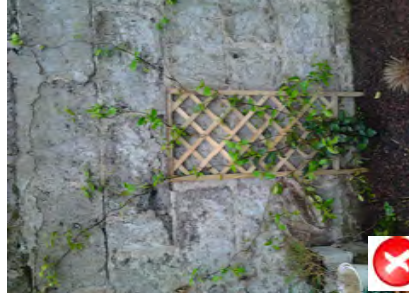
Mauvaise pratique : Végétalisation sans structure porteuse sur un mur présentant des pathologies.
