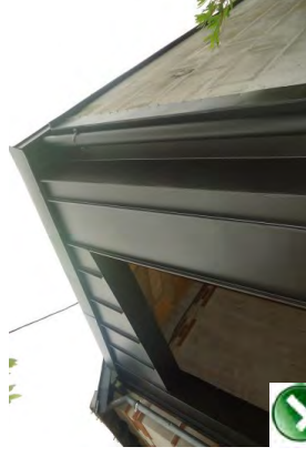
Bonne pratique : Descente d'eau pluviale intégrée
