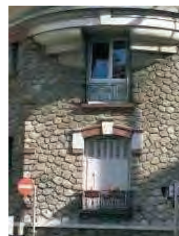
Maçonneries mixtes de briques et éléments de ciment.
