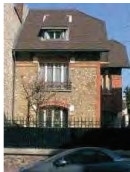
Maçonneries mixtes de briques et éléments de ciment.
