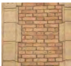
Maçonneries mixtes de briques et pierre de taille.
