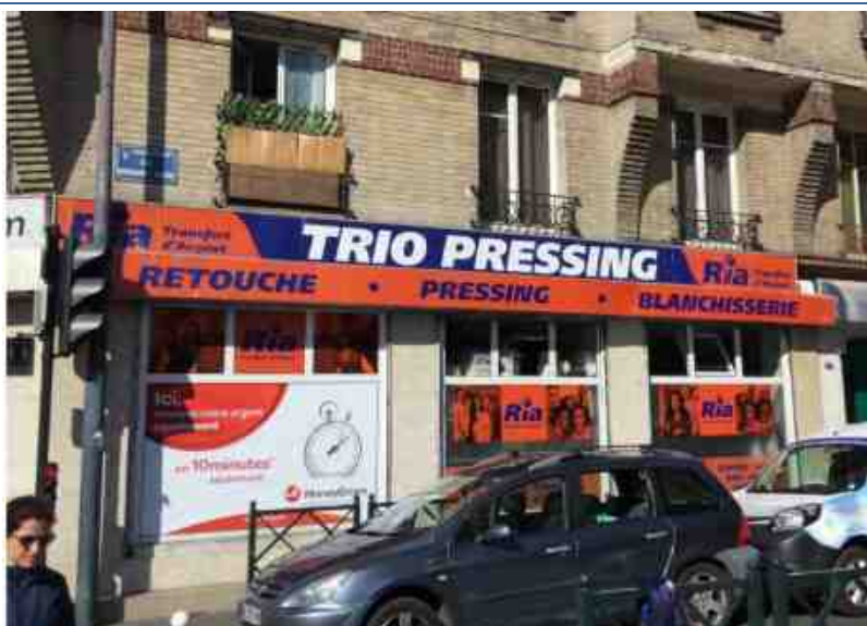
Enseigne dépassant les pourcentages autorisés, commune d'Asnières-sur-Seine
