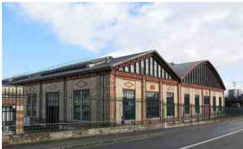
Usine élévatrice des eaux - Colombes
