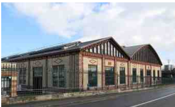
Usine élévatrice des eaux – Colombes
