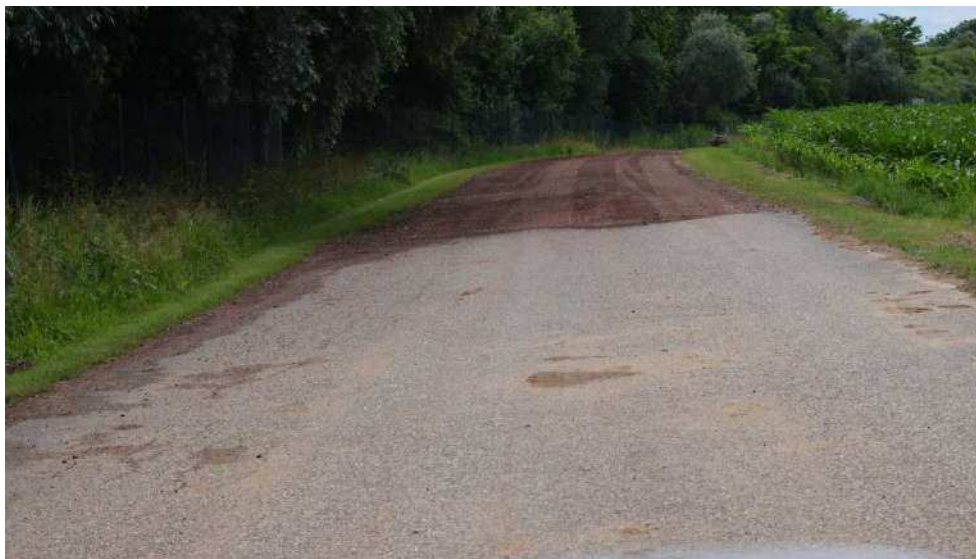
Illustration n° 2 : voie d'accès depuis la RD 468 jusqu'à l'entrée du site
