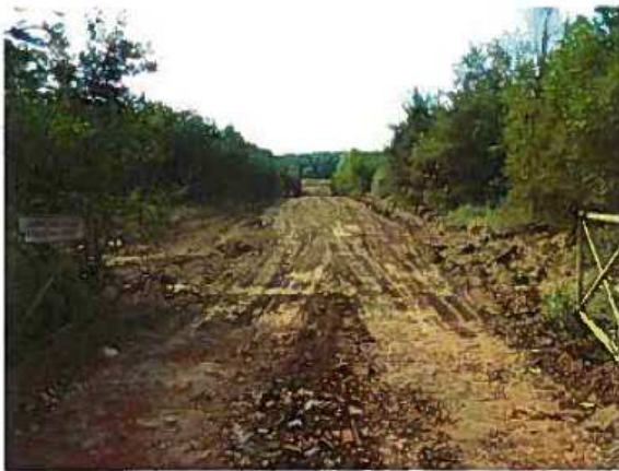
Chemin entre les parcelles 12 et 13 en cours de remise en état
