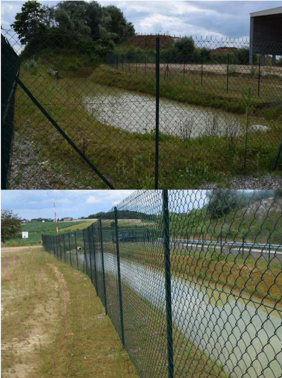
Illustration n° 4 : Bassin de récupération des eaux pluviales présents à l'entrée de la carrière de la société WIENERBERGER
