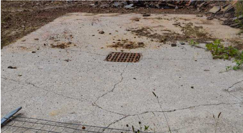
Illustration n° 5 : Aire imperméabilisée étanche munie d'un séparateur à hydrocarbures présente sur la carrière
