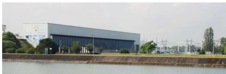
Vogelgrun Usine hydroélectrique
