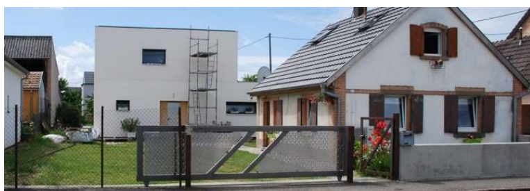
Hirtzfelden, maison contemporaine en fond de parcelle. La maison d'habitation (fin XIXème) a été réhabilitée
