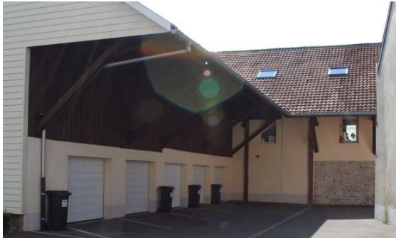
Blodelsheim : dépendance réaménagée en lofts + garages.
