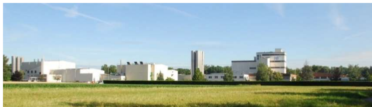
Biesheim Usine PGI (matières non tissées)
