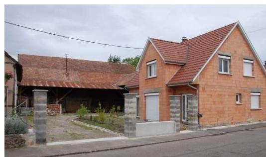
Widensolen – la dépendance ancienne est visible à l'arrière de la parcelle. La maison d'habitation contemporaine remplace sans doute l'ancienne maison d'habitation. Son pignon reste aligné en limite du domaine public.
