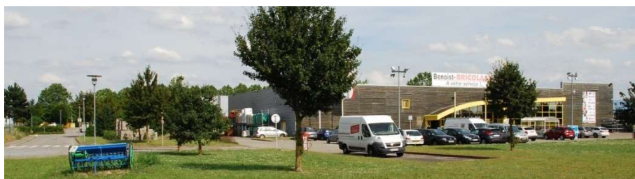
Volgelsheim : magasin de bricolage implanté à l'entrée de la zone du château d'eau
