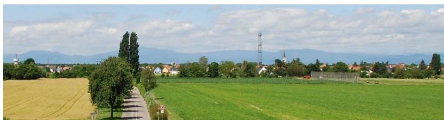
Blodelsheim vu depuis le Rhin : écran végétal du Muhlbach à l'entrée du village (rue du canal d'Alsace, au premier plan)
