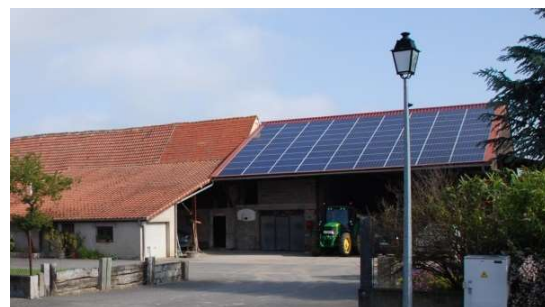
Artzenheim : dépendance maintenue dans son utilisation agricole et réinvestie comme support de panneaux photovoltaïques.
