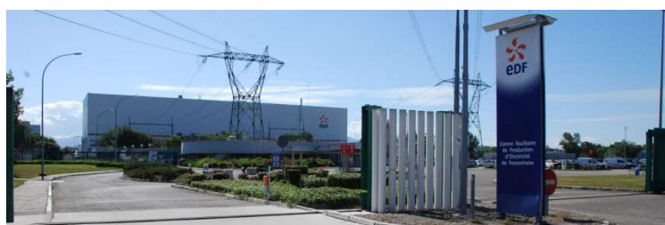
La centrale nucléaire de Fessenheim, vue depuis son portail d'entrée sur la D52.
