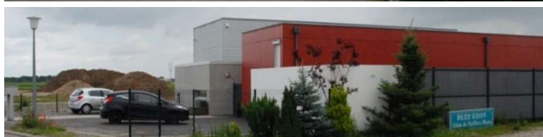
Dessenheim – zone d'activité artisanale Altech Géothermie
