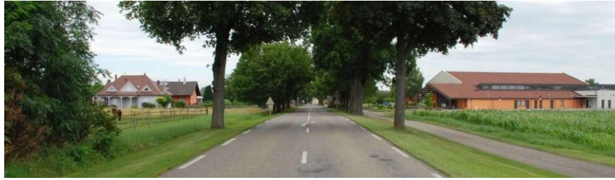
Rumersheim- le-Haut - D468 entrée sud
