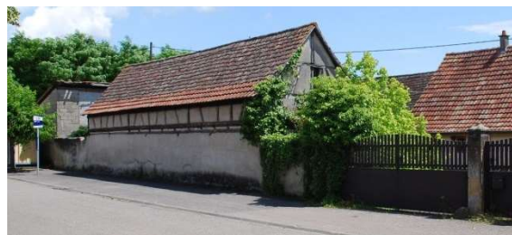
Roggenhouse : dépendance en pans de bois adossée à un mur de maçonnerie aligné sur la rue.
