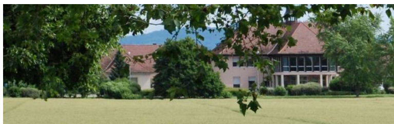
Namsheim Pôle de Recherche du groupe Dupont de Nemours, implanté rue du moulin
