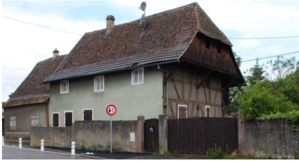
Balgau : maison à pans de bois apparents et recouverts, avec toiture à deux pans à demi-croupe. XVIIIème siècle
