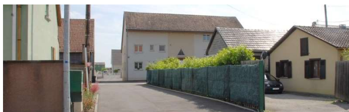
Durrenentzen – grange transformée en logement mélangée à un ensemble de constructions neuves en seconde ligne
