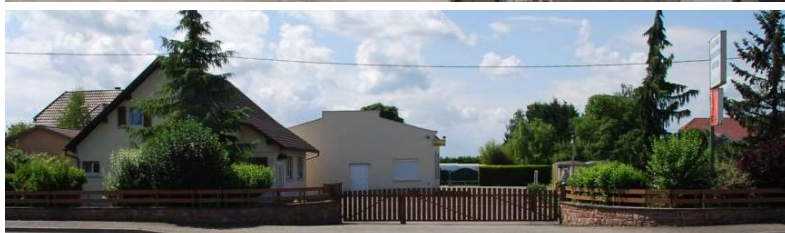
Roggenhouse : entreprise artisanale de chauffage-sanitaire, localisée route de Blodelsheim, vers la sortie ouest du village
