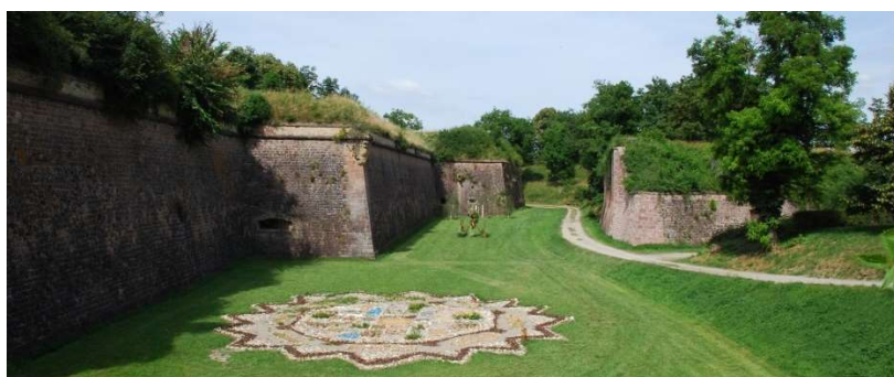
Fortifications de Neuf-Brisach à la hauteur de la porte de Bâle
