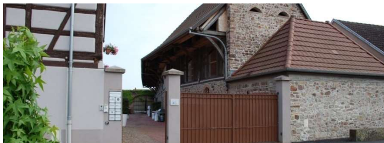
Logelheim – Corps de ferme réhabilité et affecté à des espaces d'activités tertiaires et de services
