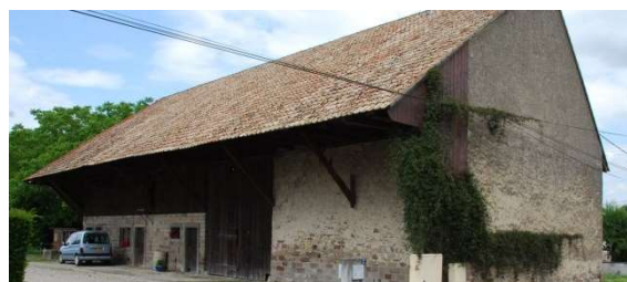
Rumersheim-le-Haut : grange réalisée sur une assise en maçonnerie de pierres de taille. Le pignon a été repris, et la toiture sans doute modifiée. La couverture de la toiture et de l'auvent, en tuiles mécaniques, remonte certainement à l'époque de la transformation de cette grange.
