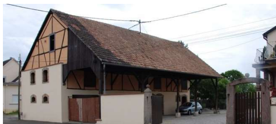
Urschenheim : dépendance avec son auvent caractéristique réalisé en charpente.
