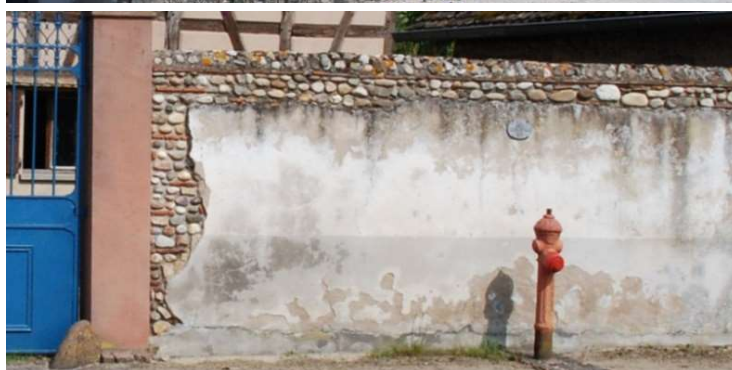
Mur de clôture à Logelheim Ici, le mur est composé de galets et de morceaux de tuiles destinés à stabiliser les assises en galets de la maçonnerie. A noter le soin avec lequel l'arrondi de la couverture a été réalisé.
