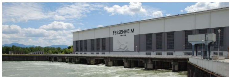
L'usine hydroélectrique de Fessenheim, l'une des plus importante du Rhin par l'énergie produite, grâce au potentiel généré par ses 16 m de chute.
