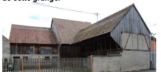
Logelheim : dépendance en maçonnerie et pan de bois, avec son auvent caractéristique en porte-à-faux.
