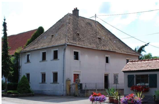
Blodelsheim : remarquable maison traditionnelle avec une toiture à quatre pans, totalement dissimulée par son enduit extérieur défraîchi, recouvrant l'ensemble de sa modénature traditionnelle. Première moitié du XIXème siècle ( ?)
