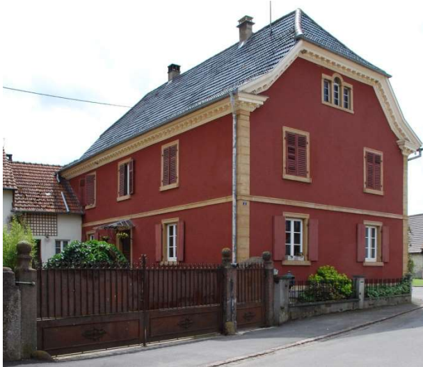
Rumersheim-le-Haut : maison traditionnelle réhabilitée en maçonnerie. La modénature présente des cadres, un sous-bassement, des chaînages d'angles et un bandeau d'étage en pierres de taille, ainsi qu'une corniche et en bois sculpté. La toiture à coyau comprend une demi-croupe, très fréquente parmi les maisons traditionnelles de la Hardt. XIXème siècle.
