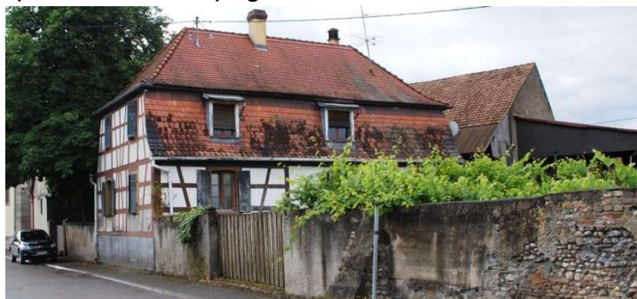
Algolsheim : maisons à pans de bois apparents, toiture à la française à deux pans brisés et à demi-croupes.
