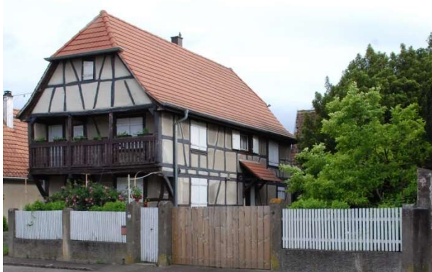
Widensolen : maison à pans de bois apparents avec toiture à deux pans à demi-croupes, avec une galerie en bois sur le mur pignon. Fin XVIIIème siècle
