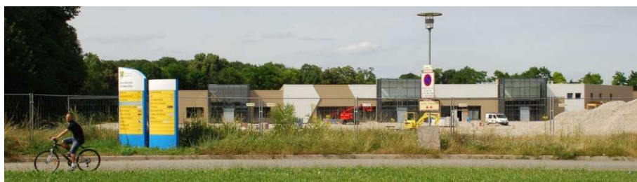
Volgelsheim : chantier en cours du nouveau supermarché - zone du château d'eau
