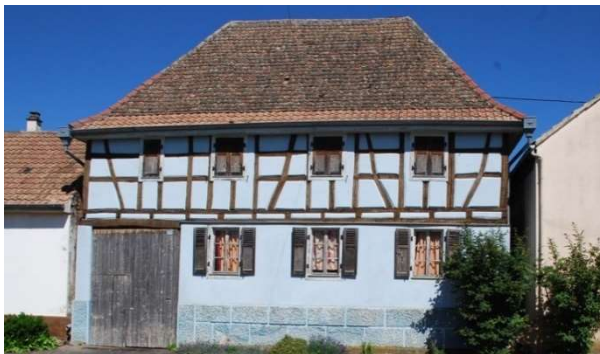
Dessenheim : maison en maçonnerie et pans de bois apparents, avec une toiture à croupes. A noter, la haute porte charretière donnant accès au porche et à la cour. Début XIXème
