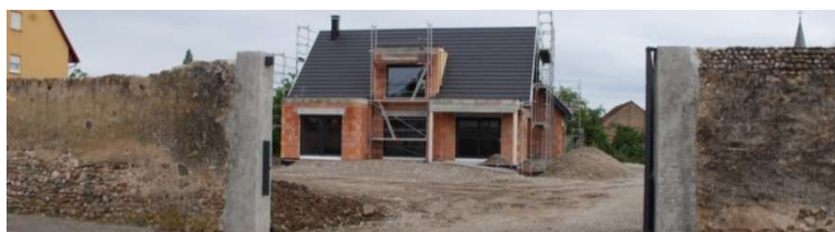
Widensolen, construction pavillonnaire en cours à l'arrière d'un mur d'enceinte traditionnel
