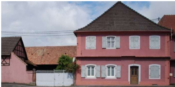
Balgau : maison en maçonnerie et pans de bois recouverts, avec une toiture à 4 pans. A noter, la modénature des cadres de fenêtres cintrés en maçonnerie de pierre de taille (rez-de-chaussée) et en bois (étage) - Fin XVIIIème
