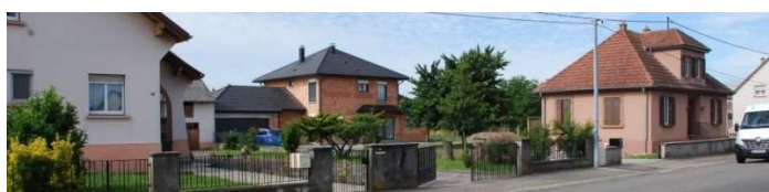
Hirtzfelden : exemple de maison individuelle en seconde ligne en cours de construction.
