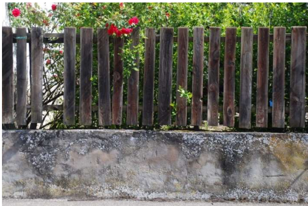
Exemple de clôture en bois sur muret en pierre à Artzenheim
