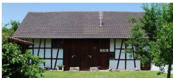
Rustenhardt : grange en pans de bois. La toiture a été remaniée pour permettre la mise en oeuvre d'une nouvelle charpente comprenant un auvent. La couverture en tuiles mécaniques est plus récente.
