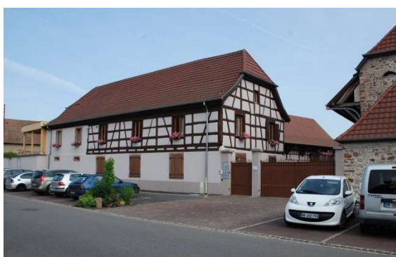
Logelheim : corps de ferme réhabilité et réaffecté en locaux d'entreprises tertiaires
