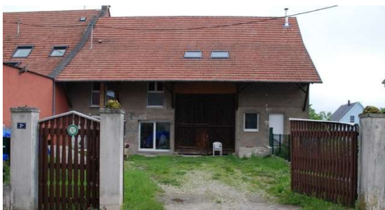
Kunheim : chantier de conversion d'une dépendance en habitation.
