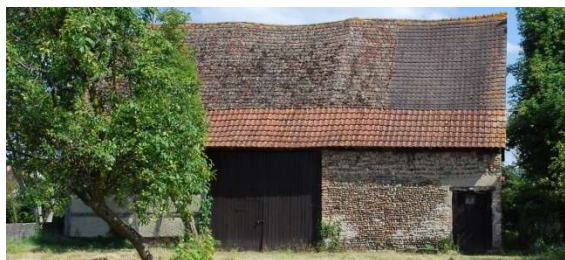
Boldelsheim : grange en pan de bois, galets du Rhin et briques plates. La toiture comprend encore la plupart de sa couverture traditionnelle en tuiles plates à simple recouvrement.
