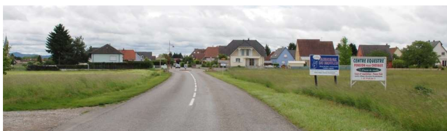
Widensolen entrée ouest (D12)
