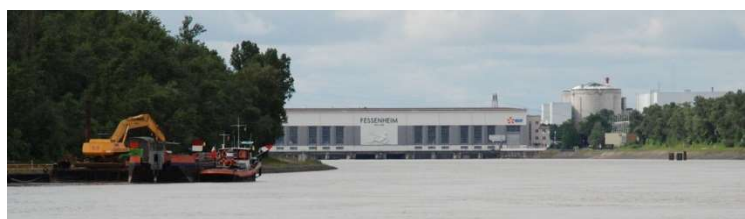
L'usine hydroélectrique de Fessenheim vue depuis le nord, avec la centrale nucléaire en second plan.
