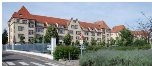
Volgelsheim – ancienne caserne convertie en logements
