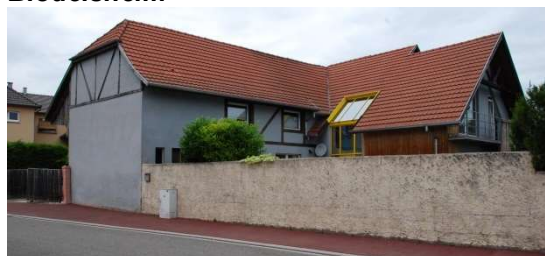
Fessenheim : dépendance traditionnelle réinvestie en habitation, avec un ajout de construction
