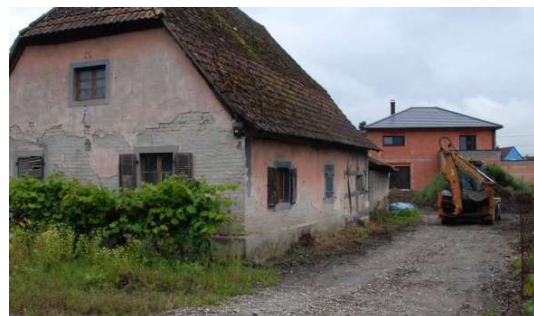
Balgau – maison à l'état d'abandon, avec, à l'arrière, à l'emplacement de la grange, une maison d'habitation en cours de construction.
