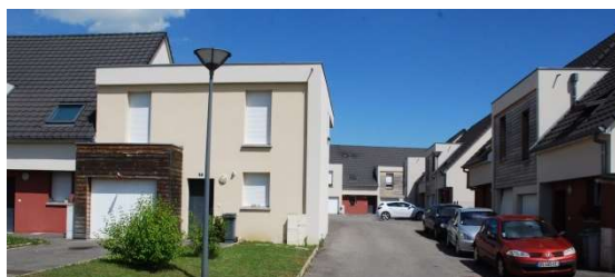
Volgelsheim – ensemble de maisons individuelles groupées
