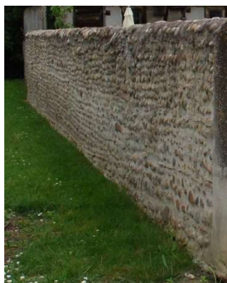
Mur de clôture à Fessenheim., composée en majorité en galets, avec quelques briques plates destinées à stabiliser quelques assises
