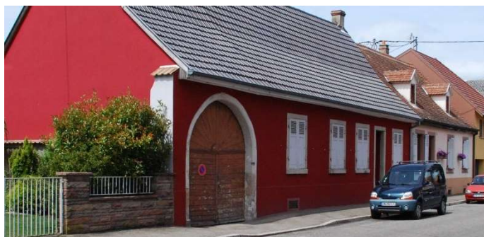
Maison à un niveau d'habitation, avec modénature simple en pierre de taille et porte charretière à plein cintre
