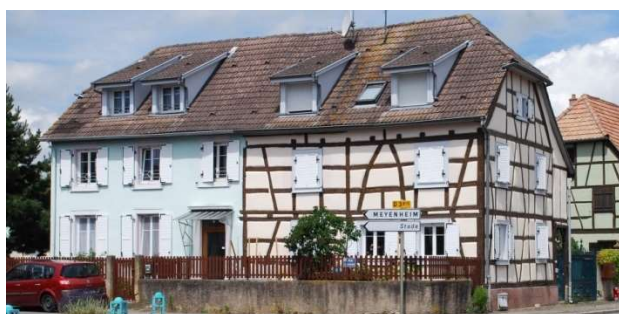
Hirtzfelden : curieux exemple de maison traditionnelle à pan de bois début XIXème siècle agrandie vers le début XXème siècle par une construction en maçonnerie. La facture de la charpente apparente laisse supposer qu'elle n'était pas destinée à être vue à l'origine.
