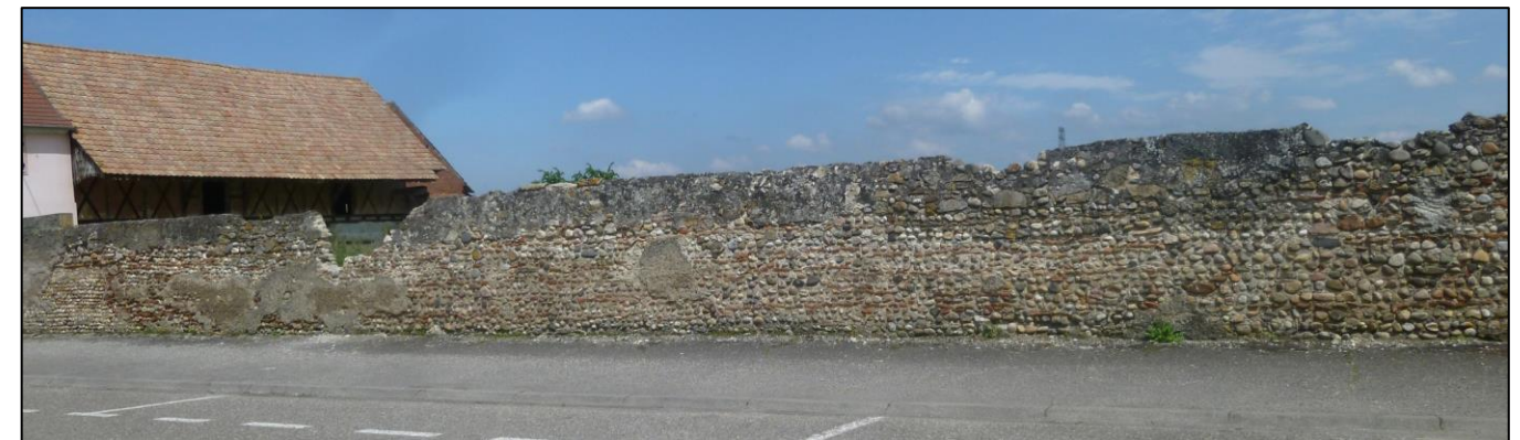
Figure 87 : Muret ancien en pierres sèches
