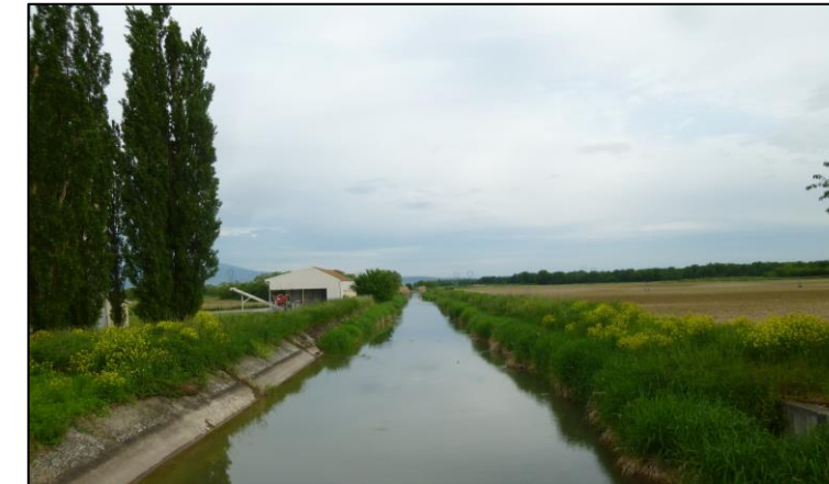
Figure 37 : Canal d'irrigation de la Hardt à Blodelsheim
