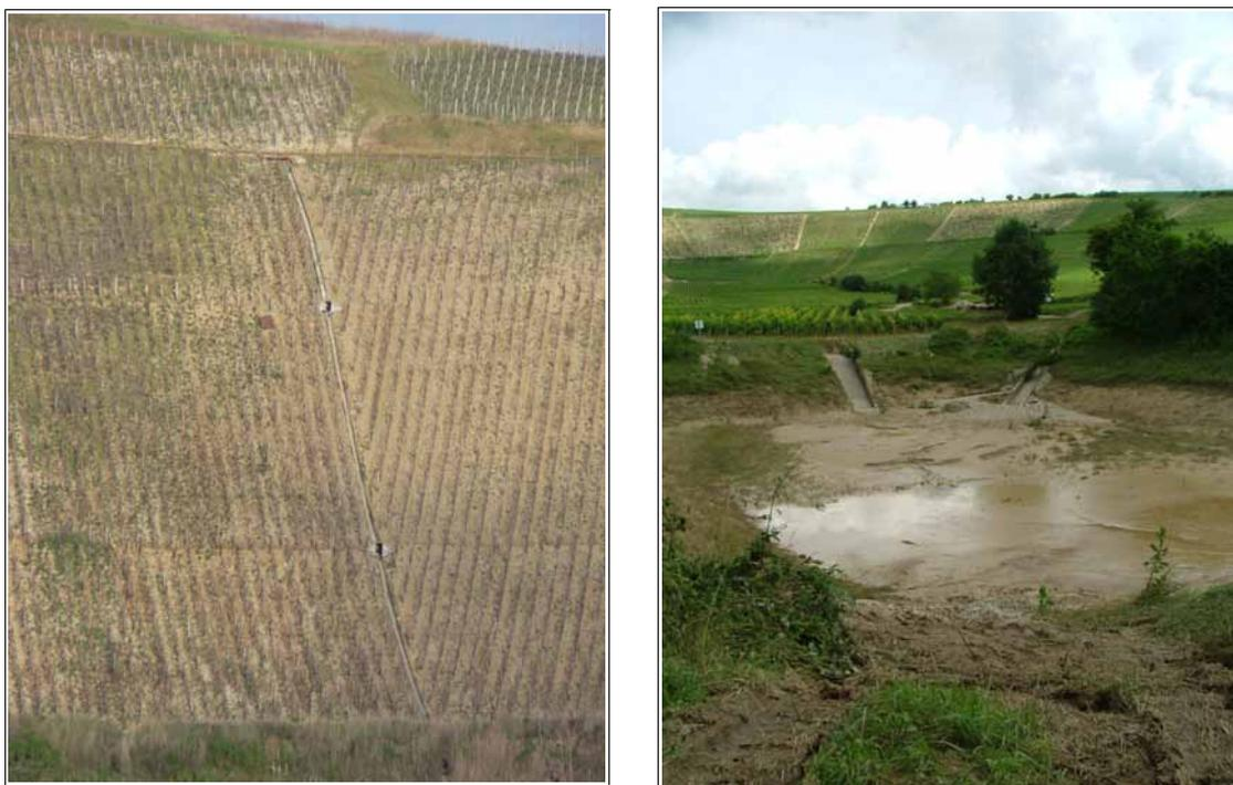
**Figure n°14 : Exemple d'aménagements artificialisant l'écoulement dans les bassins versants (canalisation/bassin d'orage)**
