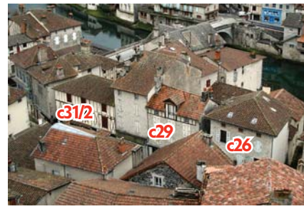
c29. Parcelle 38 rue de la Trémolière
