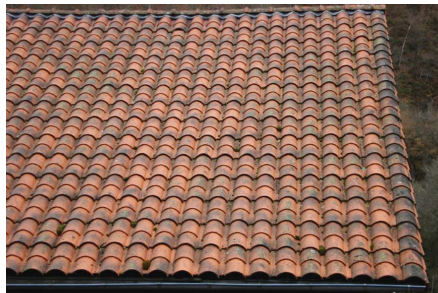
La tuile "romane" est en fait une tuile mécanique présentant (de manière plus ou moins convaincante) l'aspect de la tuile canal ou creuse traditionnelle.
