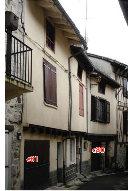
c82. Parcelle 1323 rue du Nègrerieu
