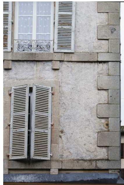
Un enduit de la fin du XIXe siècle, encore en bon état.
