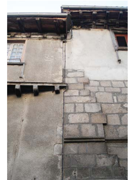
Un cas fréquent : cohabitation de parements en pierre, de maçonneries enduites, de pans de bois enduits.
