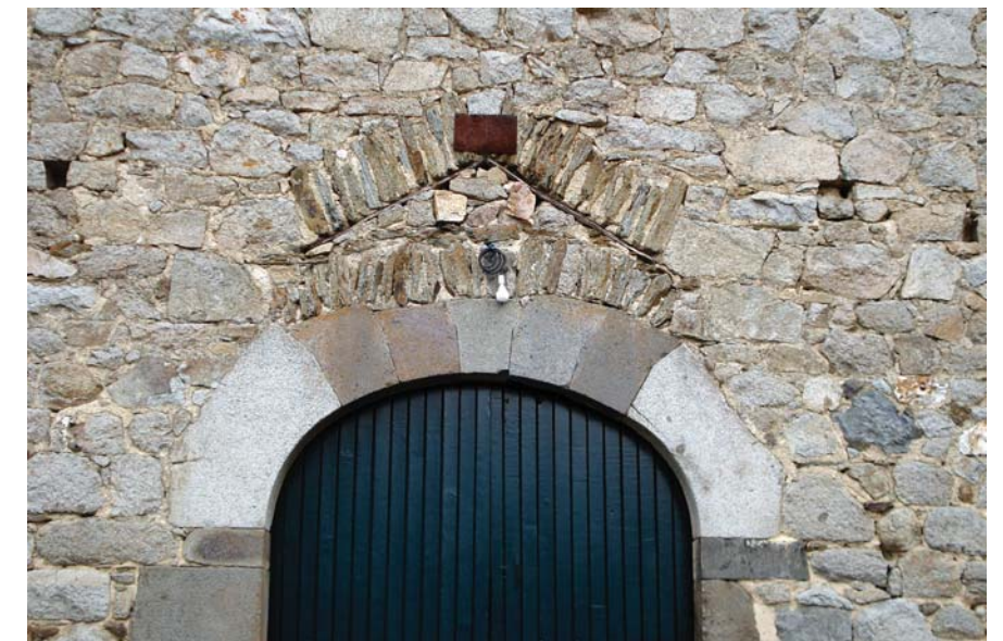
Minéraux hétérogènes en milieu rural. Il est probable que ce genre de parement était destiné à être enduit, mais ne l'a pas été, pour des raisons qui nous échappent.
