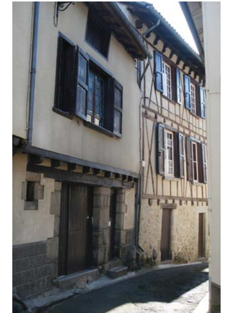
Immeuble à façade mixte, rez de chaussée maçonné et pan de bois (enduit ou dégagé). Leur datation est incertaine (postérieurs à la période médiévale ?)
