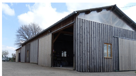
Façades en bois à bardage vertical qui respectent le règlement
