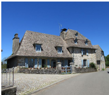
AR 02 : ancien presbytère Parcelle A706, bourg L'ancien presbytère offre un volume intéressant lié à la présence d'un comble brisé. Le bâtiment est construit en pierre avec couverture en lauze.
