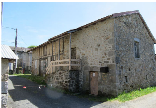
SG 11 : annexes Parcelle C184 Espinet Grange et annexes de construction mixte, pierre et pans de bois ayant conservé un caractère authentique.
