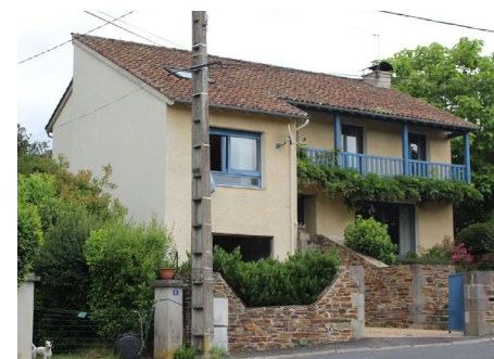
Maison en R + 1 + combles (La Roquebrou)
