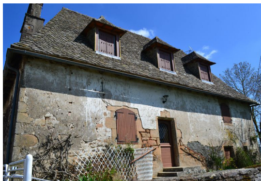
AR 14 : maison Parcelle C571, Selves Maisons accolées bien préservées. Construites en pierre et couvertes en lauze.
