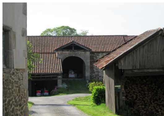
SI 16 : grange Parcelle A502 Cabanes Grange étable avec porte charretière sous porche maçonné en saillie, typique du secteur.
