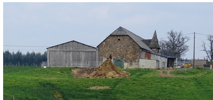
A Saint-Victor : extension d'une grange ancienne avec bardage bois laissé brut
