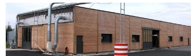
Intégration de panneaux solaires en façade sur une menuiserie à Albi (81) - Source : http://www.prixnational-boisconstruction.org
