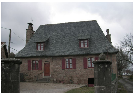
CM 05 : maison Parcelle D703, Cinqalbre Maison de village présentant un bon état de conservation.
