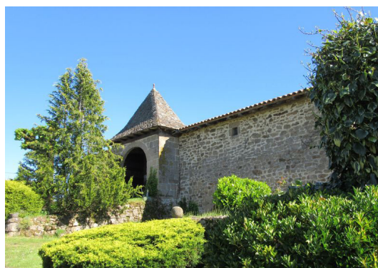
CM 04 : grange Parcelle B045, Bourg Grange étable couverte en tuile avec porte charretière précédée d'un proche maçonnerie couvert en lauze.
