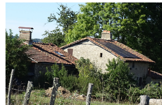
Exemple de panneaux solaires bien intégrés sur une ancienne toiture en tuile (Cros de Montvert)
