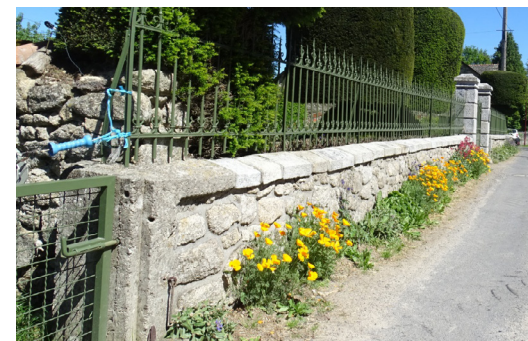
Exemple de clôture et de bas côté adaptés : mur surmonté d'une grille et fleurissement du bas côté (Rouffiac)
