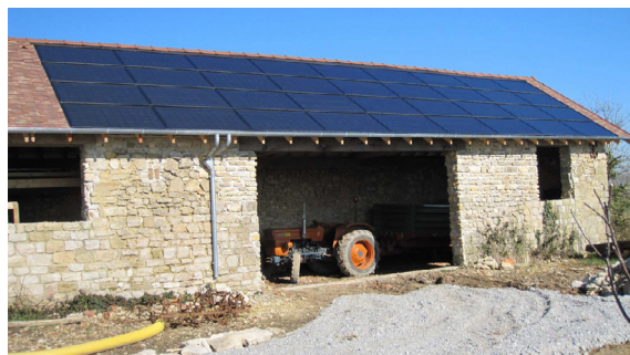
Panneaux solaires sur une vieille grange où les cadres noirs facilitent l'intégration sur la toiture (source : www.solesens.fr )
