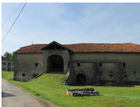
SI 17 : grange Parcelle A491, Cabanes Grange étable avec porte charretière sous porche maçonné en saillie, typique du secteur.
