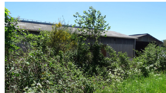
Haie multistrates diversifiée filtrant les vues sur le bâtiment (Saint-Santin Cantalès)
