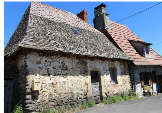
AR 11 : maison Parcelle E207, Carvagnac Logis de journalier ayant conservé ses dispositions d'origine malgré le remplacement de la partie haute de la couverture en lauze.
