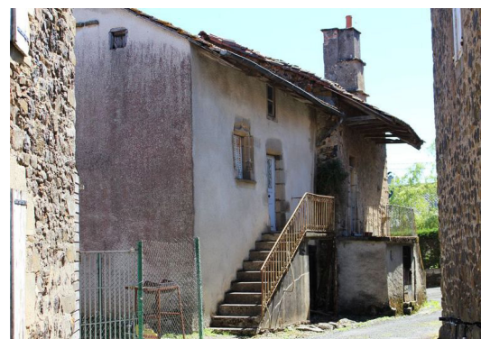
SSC 04 : maisons Parcelles B183 et B184, Bourg Maison médiévale conservant des éléments d'architecture ouvragés.
