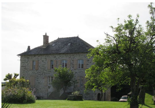
SI 15 : maison Parcelle A502 Cabanes Maison de maître en bon état de conservation.
