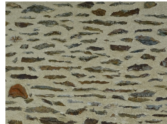
Mortier des joints entre les teintes beige et brun vert
