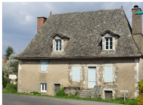
Exemple de menuiseries homogènes sur la façade (Nieudan)
