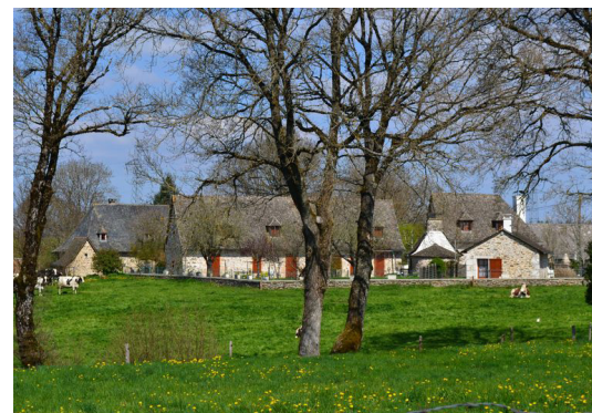
AR 15 : ensemble maison et annexes Parcelle C744, Saint-Rouffy Ensemble de maisons et annexes ayant fait l'objet d'une restauration qualitative.
