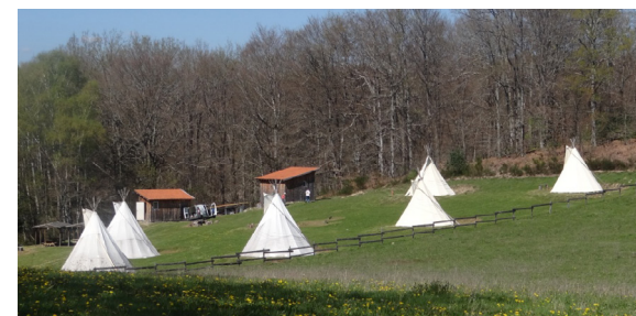
Exemple d'hébergements démontables (La Roquebrou)
