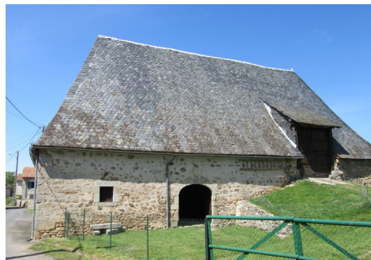
SG 08 : grange Parcelle C199, Espinet Grange étable couverte en lauze. Bâtiment typique du secteur et bien conservé.
