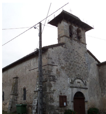
SI 18 : église Parcelle E461, La Balbarie Ancienne église paroissiale du XVIII ème siècle. Portail ouvragé.
