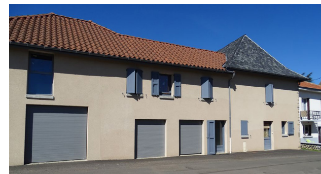
Exemple de menuiseries homogènes sur toute la façade (Saint-Santin Cantalès)
