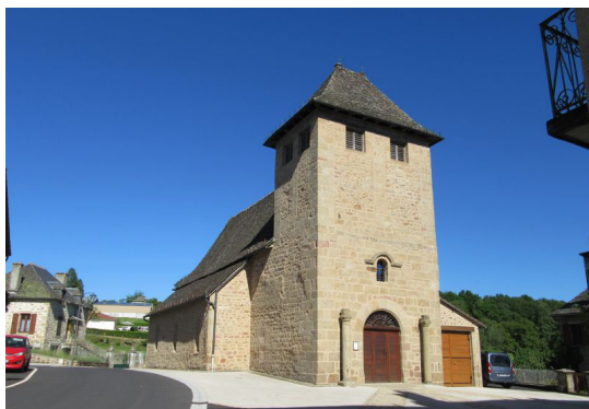
CM 01 : église Parcelle B065, Bourg L'église marque l'entrée sud du village par son volume massif avec chevet plat et clocher porche.
