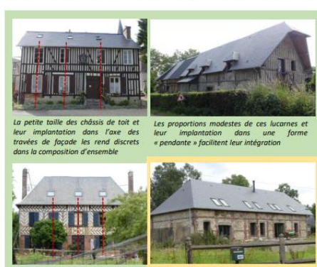
Bien que bien positionnés en bas du rampant, dans le nu du toit, de taille modeste, alignés horizontalement et en lien avec les travées de la façade, ces châssis de toit sont trop nombreux et trop rapprochés, créant une présence trop forte en toiture.
