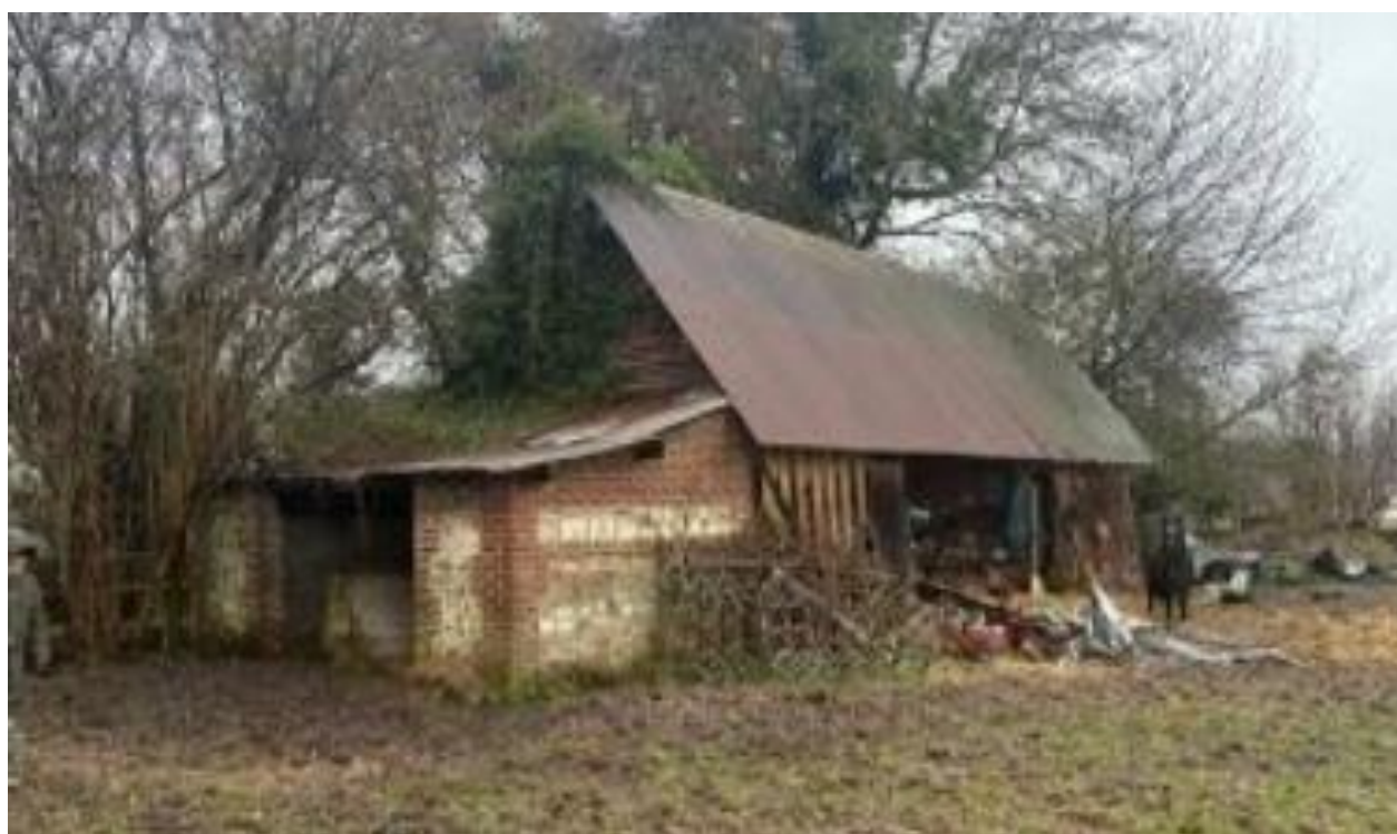
Figure 55: Photographie du bâtiment concerné par le changement de destination
