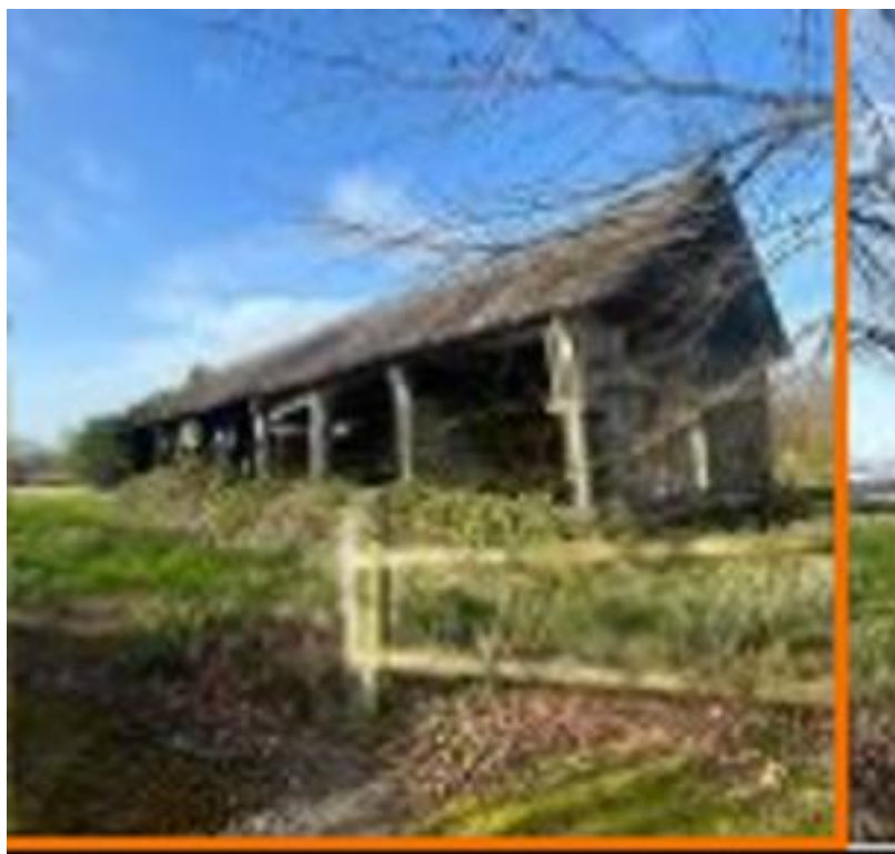
Figure 71 : Photographie du bâtiment concerné par le changement de destination
