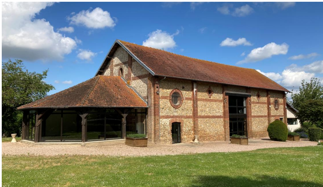
Figure 57 : Photographie du bâtiment concerné par le changement de destination
