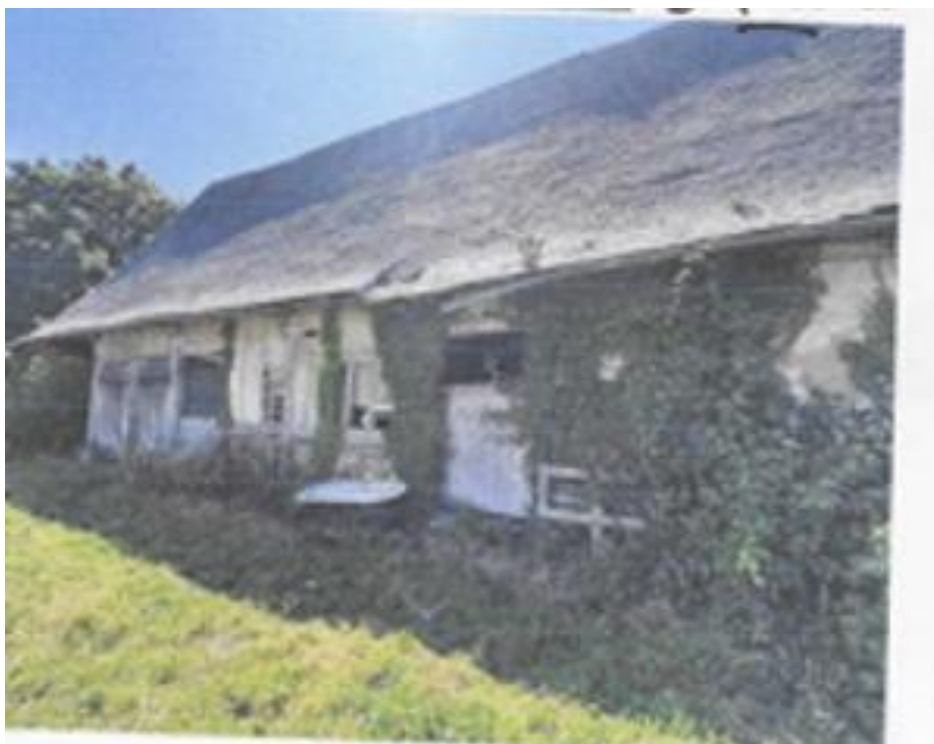
Figure 61 : Photographie du bâtiment concerné par le changement de destination
