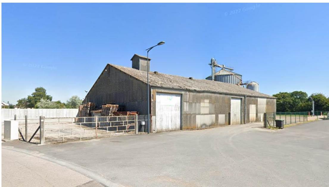
Figure 2 : Bâtiment actuel de la société Natup qui est ancien
