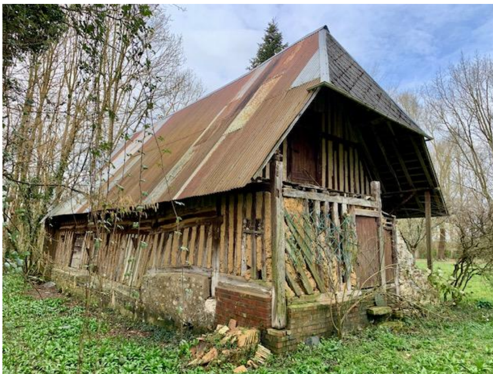
Figure 69 : Photographie du bâtiment concerné par le changement de destination
