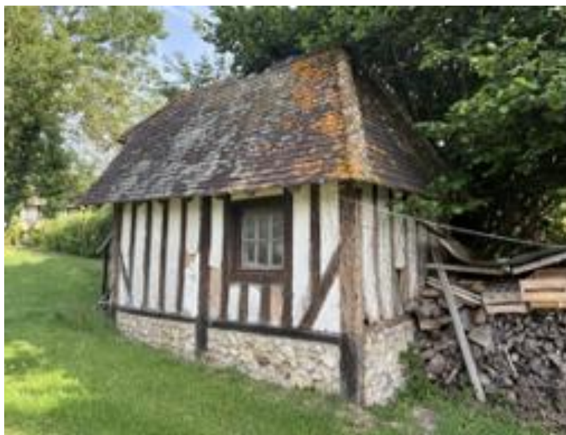
Figure 73 : Photographie du bâtiment concerné par le changement de destination
