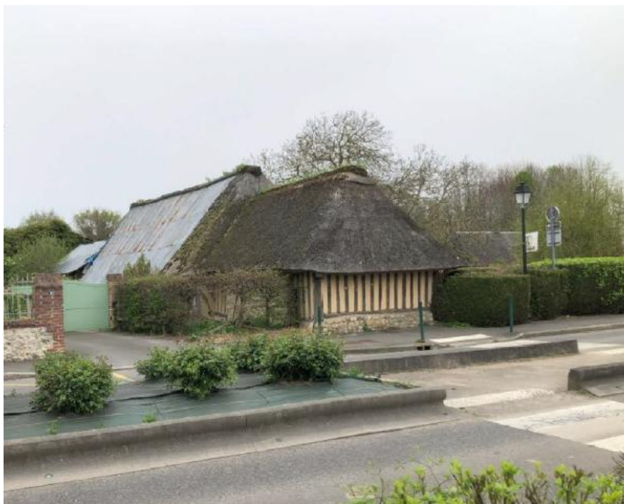
Figure 87 : Photographie du bâtiment concerné par le changement de destination
