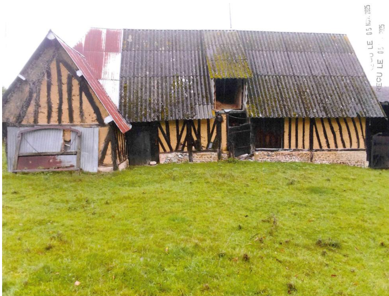
Figure 67 : Photographie du bâtiment concerné par le changement de destination
