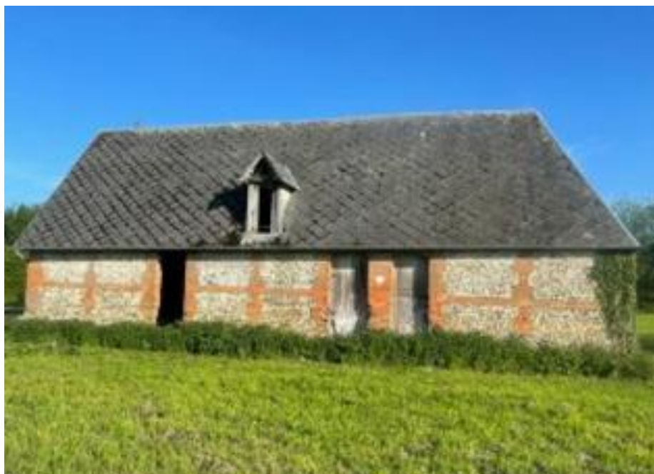
Figure 101 : Photographie du bâtiment concerné par le changement de destination
