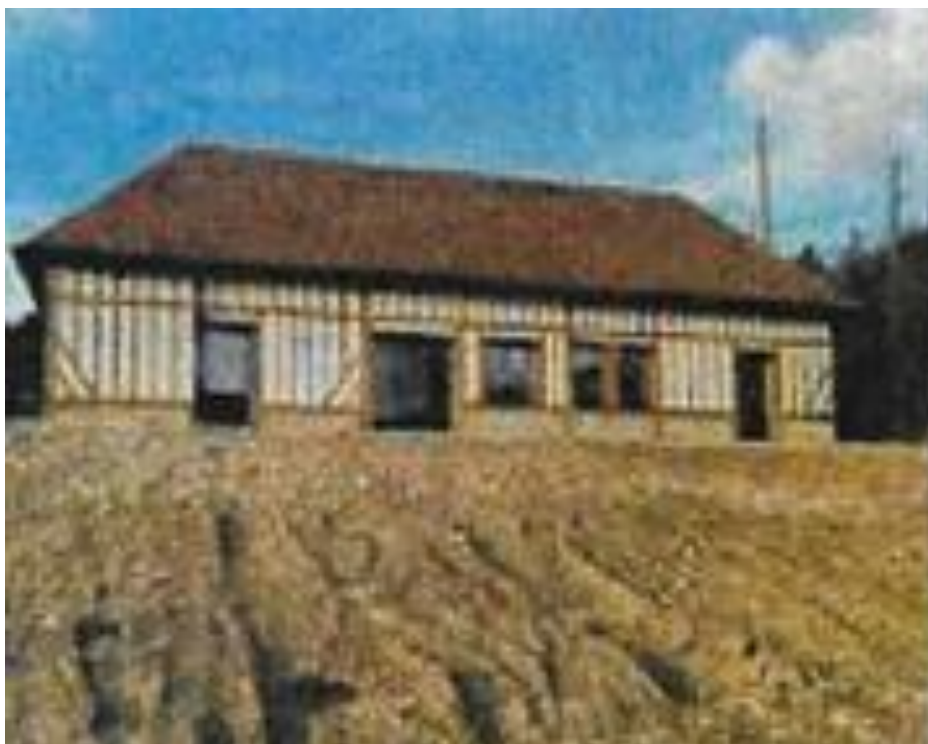
Figure 63 : Photographie du bâtiment concerné par le changement de destination
