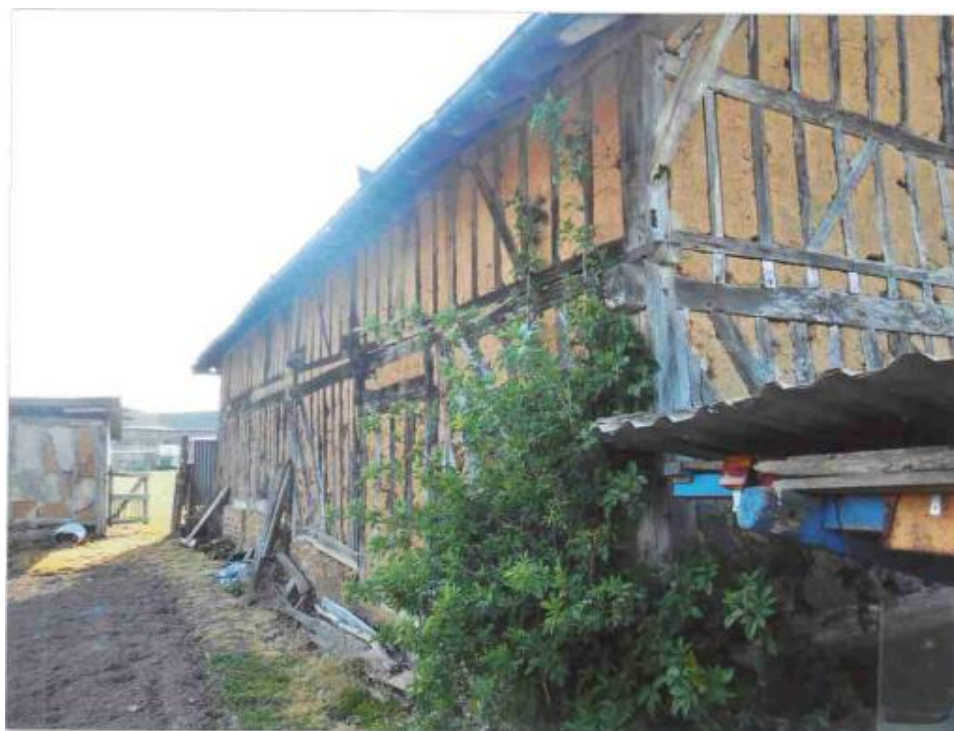
Figure 47 : Photographie du bâtiment concerné par le changement de destination
