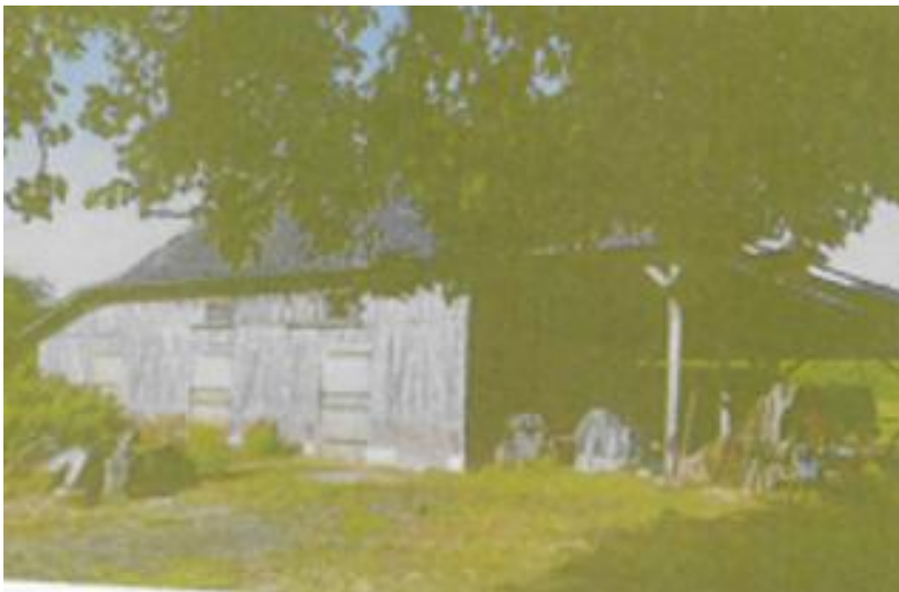
Figure 85 : Photographie du bâtiment concerné par le changement de destination
