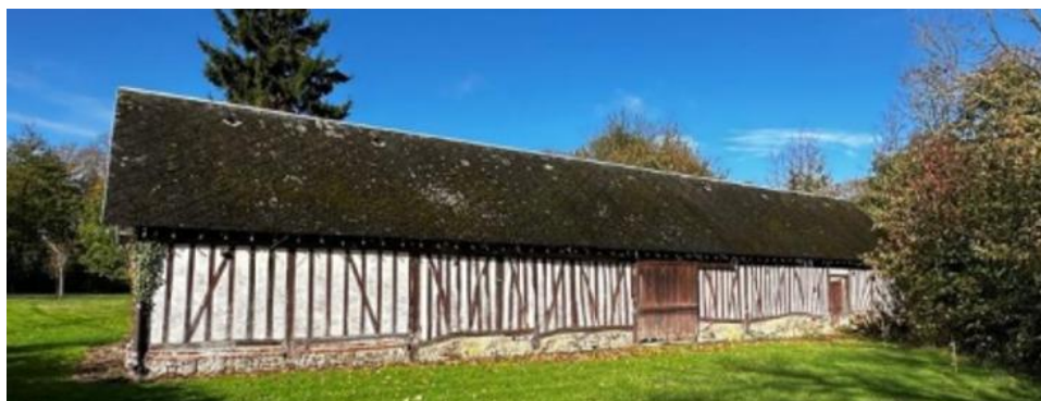
Figure 81 : Photographie du bâtiment concerné par le changement de destination
