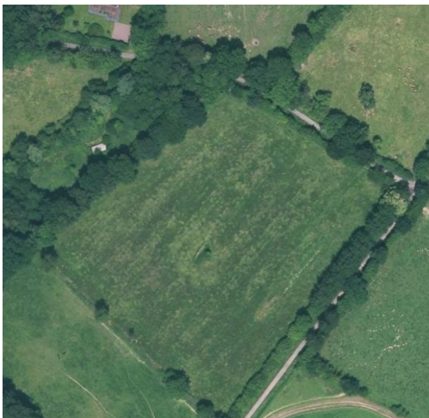
Figure 44 : Vue aérienne du site entre 2016 et 2020 (source orthophoto IGN)
