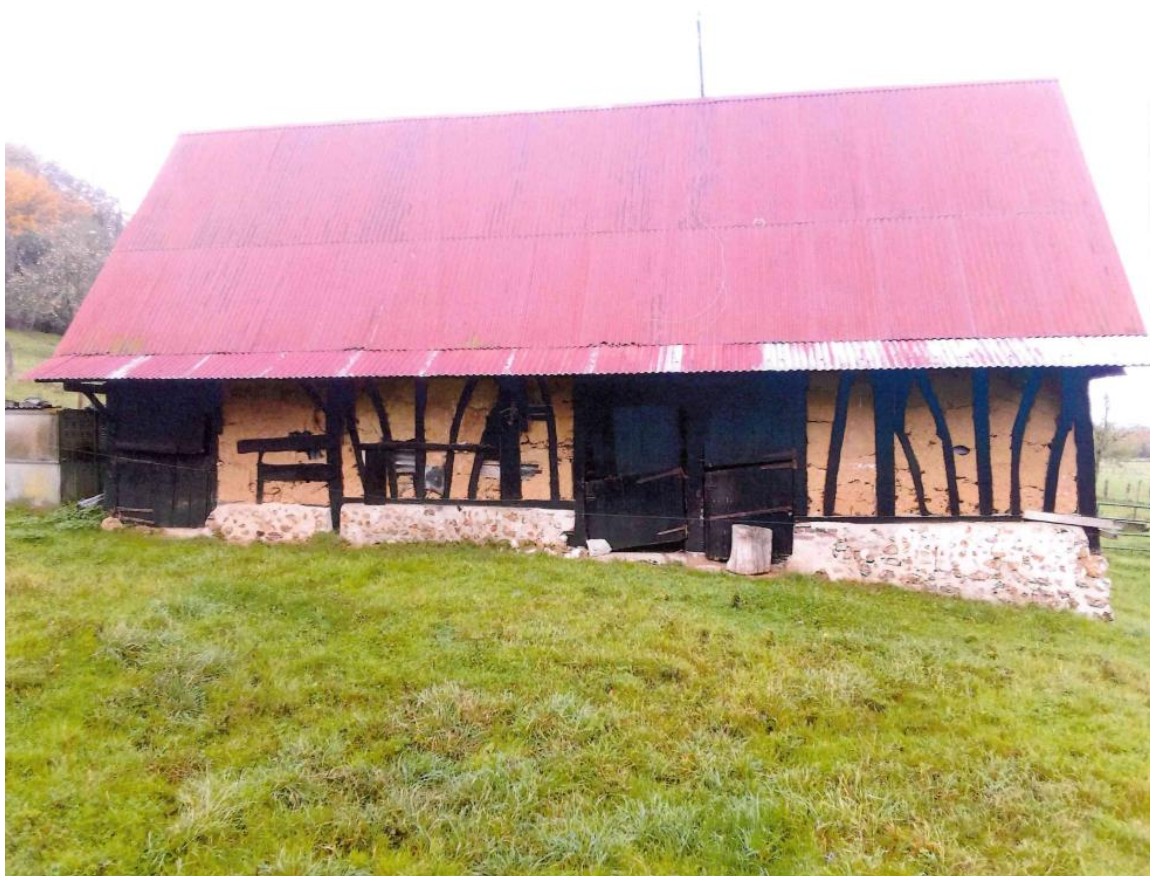
Figure 65 : Photographie du bâtiment concerné par le changement de destination
