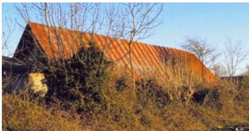
Figure 75 : Photographie du bâtiment concerné par le changement de destination
