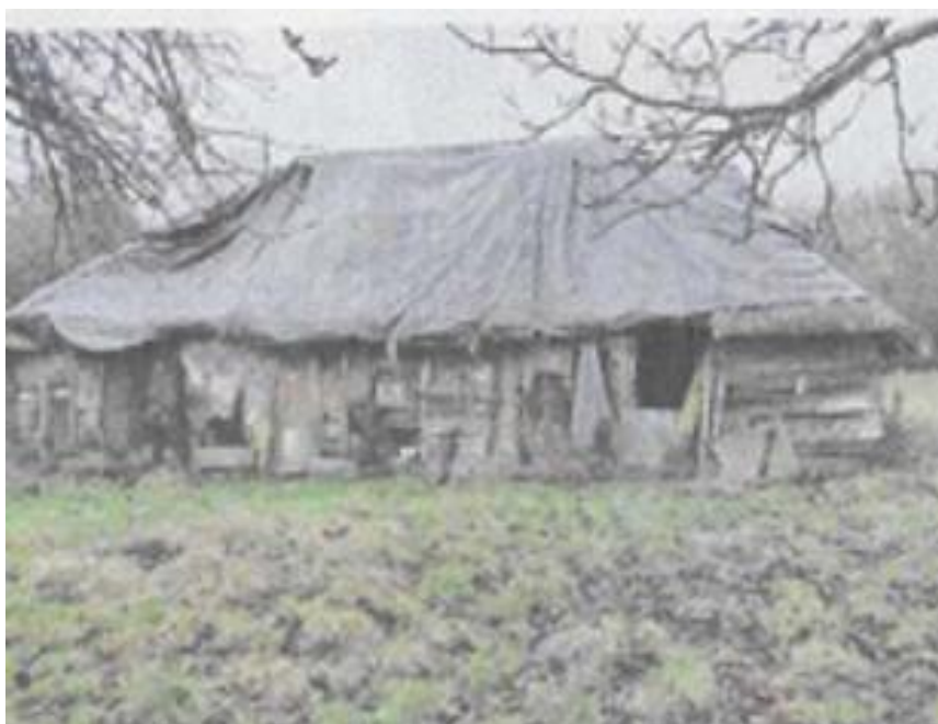
Figure 99 : Photographie du bâtiment concerné par le changement de destination
