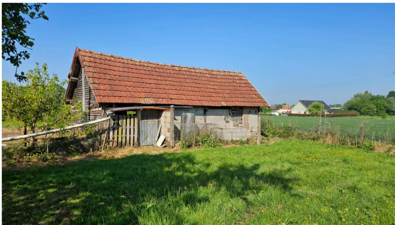
Figure 49 : Photographie du bâtiment concerné par le changement de destination
