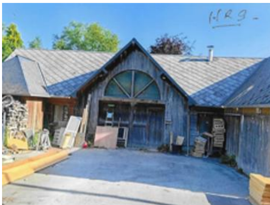
Figure 91 : Photographie du bâtiment concerné par le changement de destination
