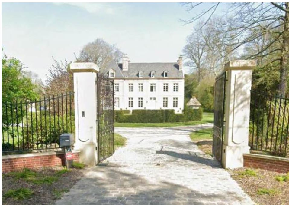
Figure 79 : Photographie du bâtiment concerné par le changement de destination
