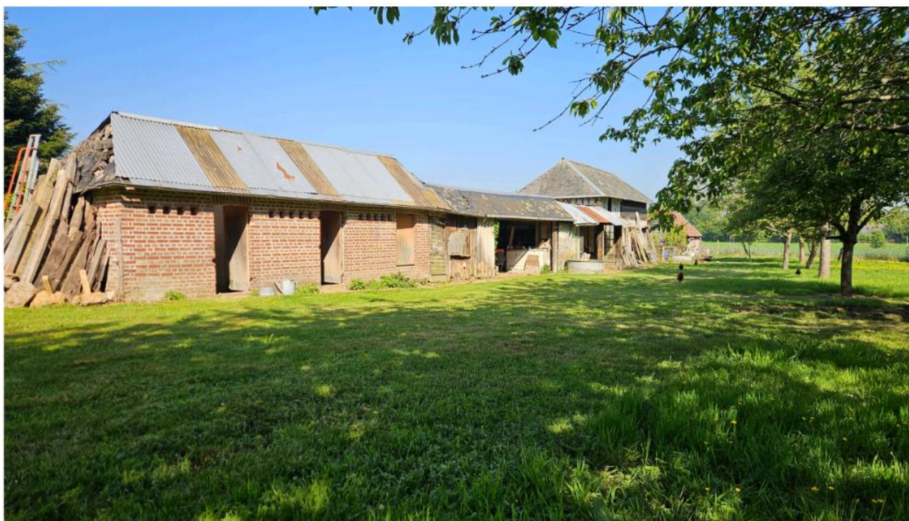
Figure 51 : Photographie du bâtiment concerné par le changement de destination
