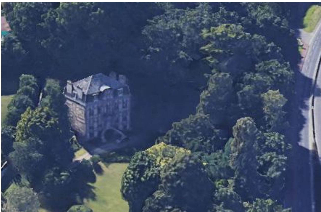
Figure 83 : Photographie du bâtiment concerné par le changement de destination
