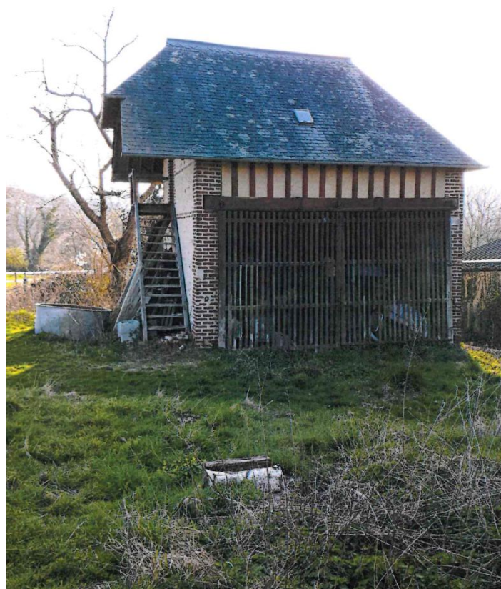
Figure 89 : Photographie du bâtiment concerné par le changement de destination
