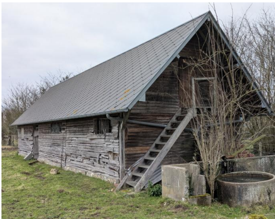
Figure 59 : Photographie du bâtiment concerné par le changement de destination
