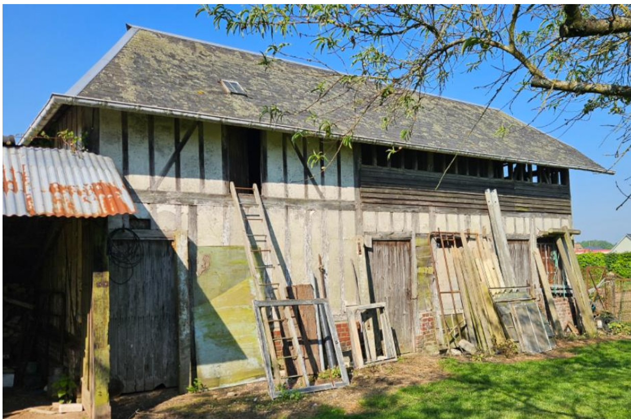
Figure 53 : Photographie du bâtiment concerné par le changement de destination
