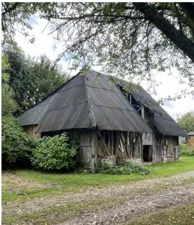
Figure 95 : Photographie du bâtiment concerné par le changement de destination
