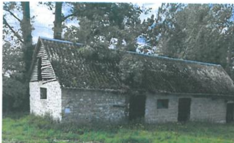
Figure 93 : Photographie du bâtiment concerné par le changement de destination
