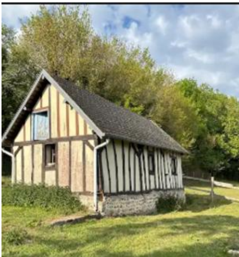
Figure 97 : Photographie du bâtiment concerné par le changement de destination
