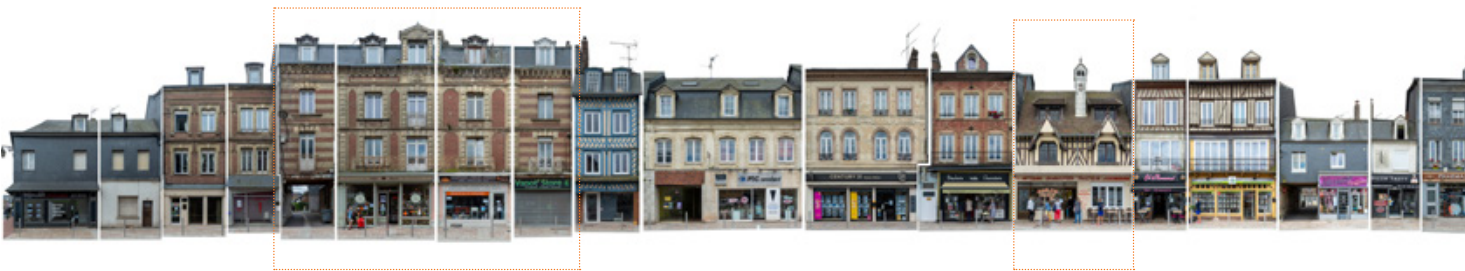
Façade Sud Rue Constant Fouchet
