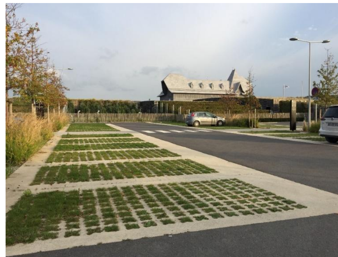
Places de stationnement désimperméabilisées à Honfleur
