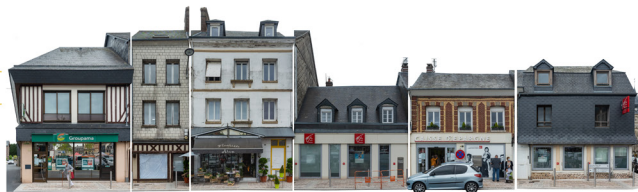
Façade Est Rue de la République
