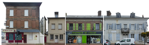
Façade est Place du GI Leclerc
