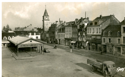
Place de la République, vue sur la Rue Constant Fouché
