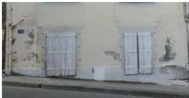
Traces d'humidité sur un mur ancien enduit au ciment. L'eau stockée dans le mur ne parvient pas à s'évacuer.
