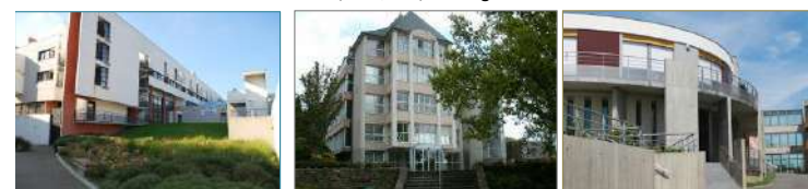
Résidence Brocéliande, Maison de retraite Le Cosquer, EHPAD Le Bourgneuf à Loudéac, Le Quillio, Merdrignac
