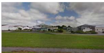
Zone d'activité de Kerjoly à Corlaix
