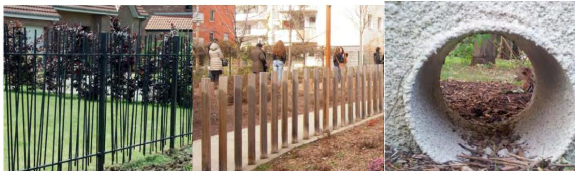
*Schéma n°1. Exemple de séparation perméable à la petite faune – Ouverture en pied de murs*
