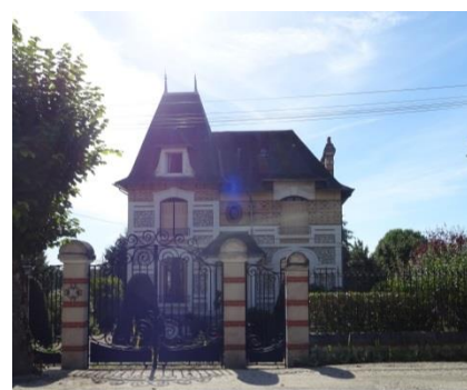
Figure 130 : Construction de la première moitié du 20 ème à Bonny-sur-Loire
