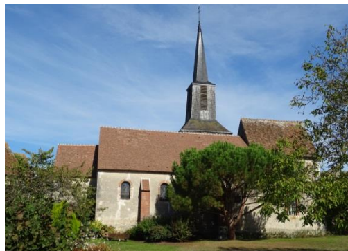
Figure 250 : Vue de l'église depuis les bords de Loire
