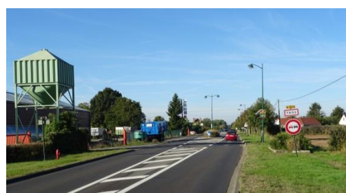
Figure 153 : Entrée Est de Thou avec perception sur les activités et les extensions récentes
