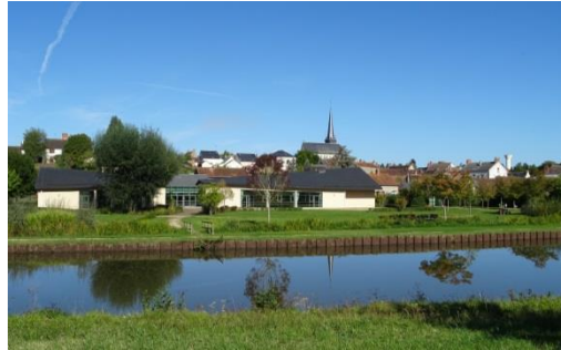
Figure 238 : Le canal de Briare accompagne la limite du bourg
