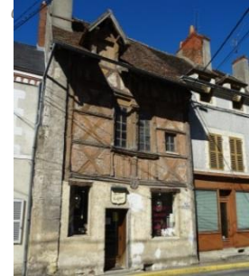
Figure 217 : Maison à pans de bois
