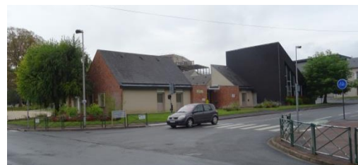
Figure 202 : Construction de Châtillon-sur-Loire
