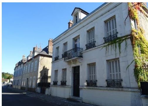
Figure 193 : Maison bourgeoise de Briare avec bandeau de façade, balcon, garde-corps ouvragé, corniche et lucarne à fronton
