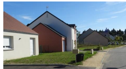
Figure 200 : Dernière extension récente de Briare
