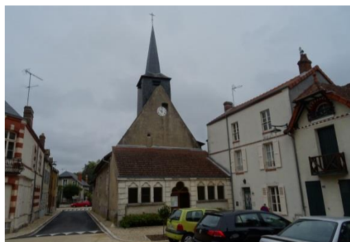
Figure 268 : Centre ancien de taille modeste
