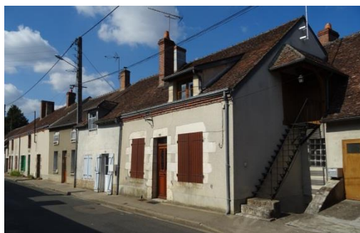
Figure 192 : Bâtiment R + combles d'Autry-le-Châtel
