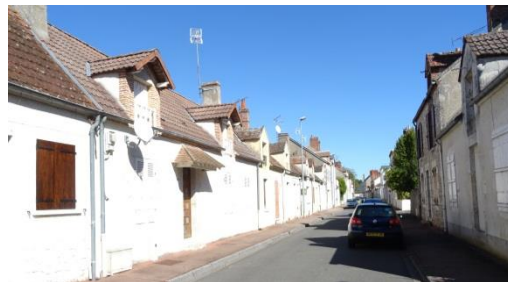
Figure 240 : Bâti d'origine rurale
