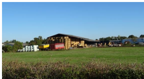
Figure 256 : Importante ferme en limite du bourg
