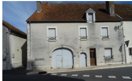
Figure 190 Maison de Bonny-sur-Loire couverte en tuile plate de pays avec porte cochère
