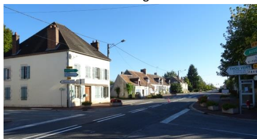
Figure 256 : Urbanisation en rive de la RD 965
