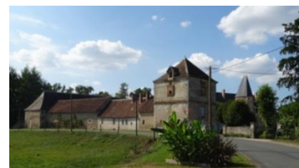
Figure 219 : Le petit château d'Autry-le-Châtel
