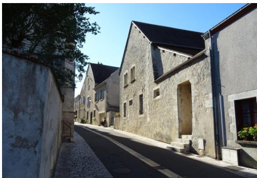
Figure 121 : Rue Haute de Châtillon-sur-Loire
