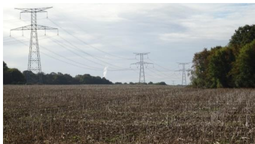
Figure 68 : Parcelle agricole traversée par une ligne haute tension
