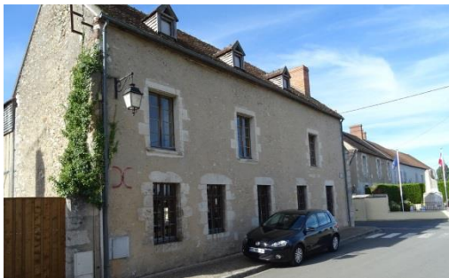
Figure 190 : Maison R + 1 + combles d'Ousson-sur-Loire avec entourage des ouvertures en pierre calcaire
