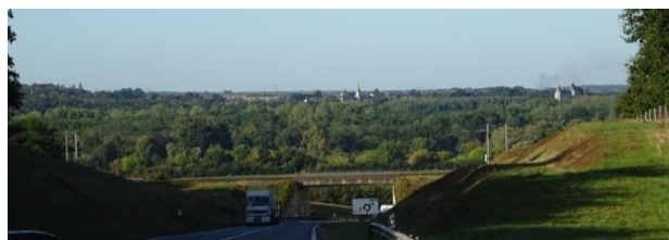
Figure 23 : Vue sur le château de Saint-Brisson depuis la RD 952 à Briare
