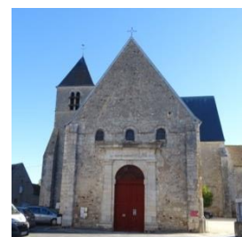
Figure 215 : Eglise de Beaulieu-sur-Loire
