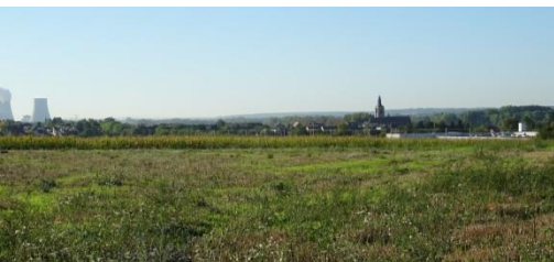
Figure 15 : Depuis les hauteurs au Nord du bourg, la centrale de Belleville est souvent présente en fond de perspective
