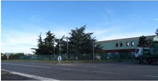
Figure 141 : Activités en rive de la RD 2007 au Sud-Est de Briare
