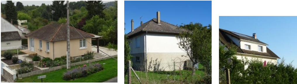
Figure 198 : Pavillons à Saint-Firmin-sur-Loire, Champoulet et Faverelles
