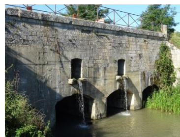
Figure 228 : Ouvrage du canal à Beaulieu-sur-Loire
