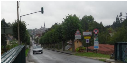
Figure 160 : L'entrée de Châtillon-sur-Loire au niveau du fleuve offre une perception sur l'église
