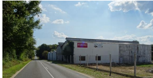
Figure 141 : Activités en rive de la RD 53 au Nord d'Autry-le-Châtel
