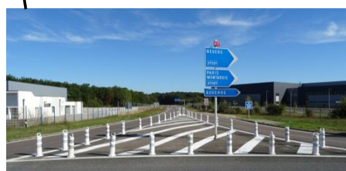
Figure 137 : Zone d'activités de Briare localisée au niveau de l'accès à l'autoroute A77
