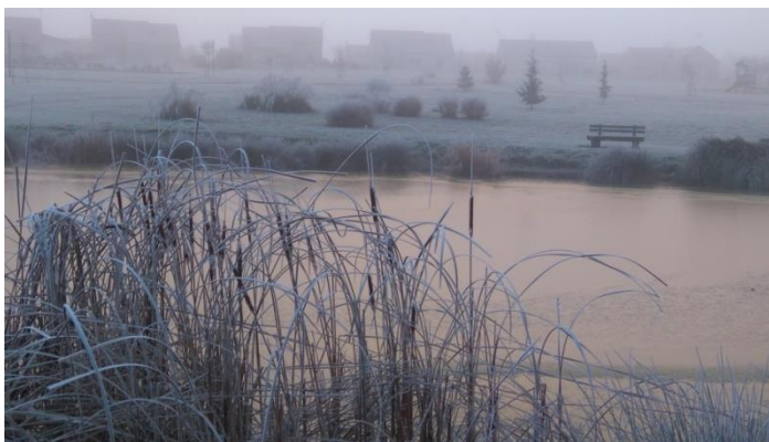
Bassin de rétention, urbanisation récente (Vatan)
