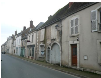
Ordonnancement régulier du bâti dans le centre : alignement et mitoyenneté
