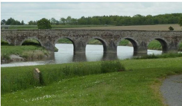
Pont de Pontaubault
