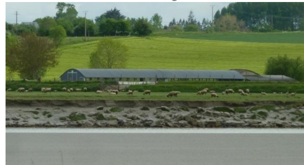
Implantation maîtrisée d'un bâtiment agricole en rive de la Baie
