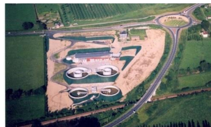
Station d'épuration de Lisieux
