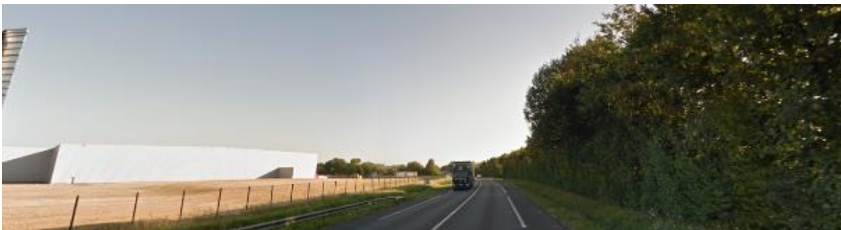
13 - Une haie masque la future zone d'activités des Caillaudières depuis la RD1763. La zone d'activités du Vendéopôle Vendée Sud Loire 2 apparaît brutalement avec une construction bloc et sans aménagement paysager d'accompagnement.
