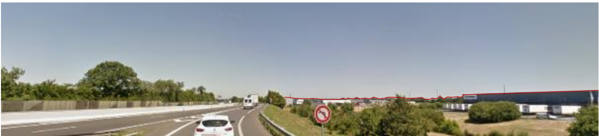
6 – La voie d'insertion à la RD1763 surplombe la zone d'activités du Point du Jour. Les quelques bosquets en première ligne rythment naturellement la zone d'activités. Les constructions se fondent sur la ligne d'horizon.
