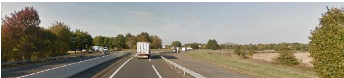
10 – Le futur secteur d'activités des Caillaudières se dévoile à l'approche du rond-point.
