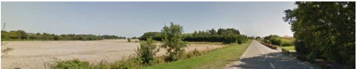
Vue sur le site et le rond-point d'accès à l'autoroute depuis la RD763.
