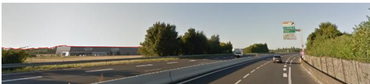
9 – La faible hauteur des constructions et l'encaissement de leur implantation par rapport à la voie leur permettent de s'intégrer dans leur environnement. La ligne de toit des bâtiments se fond / confond avec la ligne des végétaux à l'arrière-plan.
