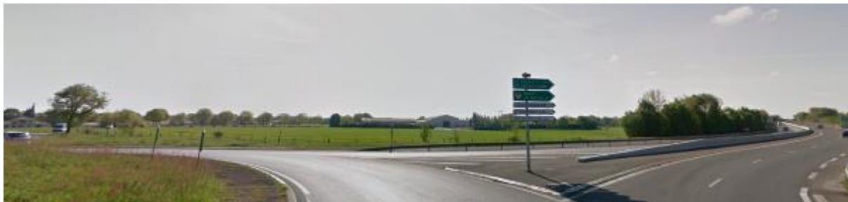
Le secteur Sud du futur secteur d'activités des Caillaudières est fortement visible depuis le rond-point et notamment depuis la voie de la sortie d'autoroute.
