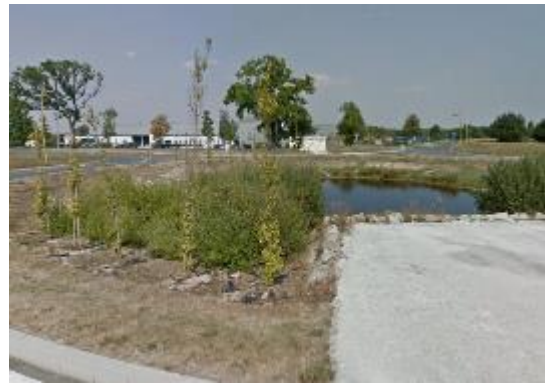
Gestion des eaux pluviales sur les ronds-points
