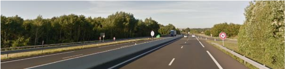
12 – La fin de la traversée de cet ensemble de zones d'activités se termine par une masse boisée dense à l'Est de la voie. Elle crée un réel écran visuel entre la RD763 et le site d'extension.
