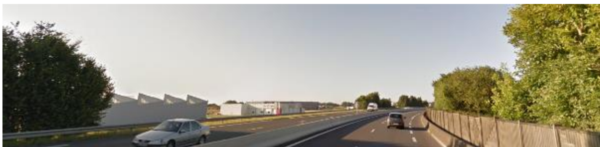
8 – Les longues interruptions de haies offrent une large fenêtre visuelle sur la zone d'activités du Point du Jour.
