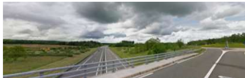
1/ Entrée nord-est – Vallée de la Vezouze
