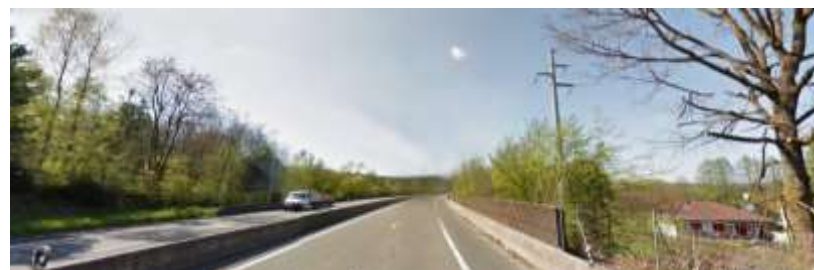
2/ Entrée sud-est – Vallée de la Meurthe/Vosges
