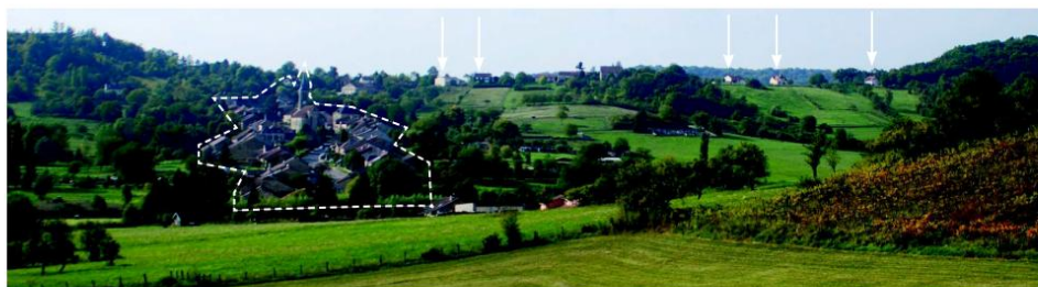
Fragilisation d'un site bâti spectaculaire par la construction non maîtrisée sur les crêtes.
