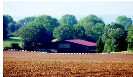
Bel exemple d'intégration de bâtiment d'exploitation dans le paysage : couleur sombre (bois) appuyé arboré et positionnement en creux à la faveur d'un vallon.
