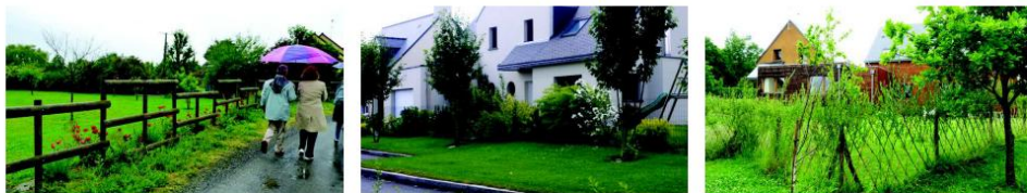
Exemples intéressants de traitement de limites de parcelles : en barrières de bois accompagnées de quelques arbres, en haies mixtes ou en osier tressé. Rennes Métropole (35)
