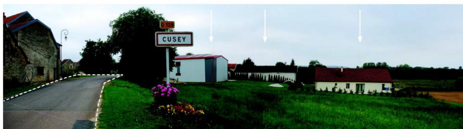
Exemple d'entrée de village banalisée par des extensions récentes en contrebas de la route, fragilisant le paysage agricole et le site bâti ancien.
