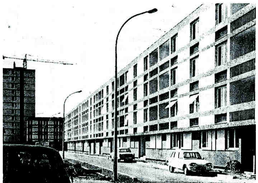
Plan de Masse et photographie chantier de construction (Documents SALEM de la Ville de Bergerac - 1967)
