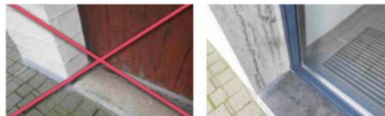
Châssis en bois / Châssis en aluminium
