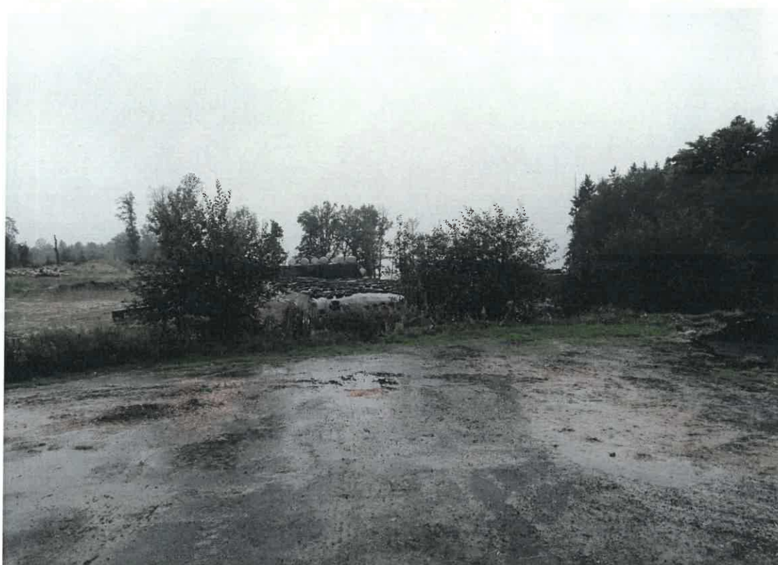
Vues sur la zone d'implantation du nouveau bâtiment (photos du 14 septembre 2017)
