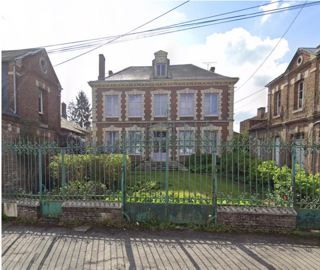
Clôture ajourée posée sur un mur bahut
