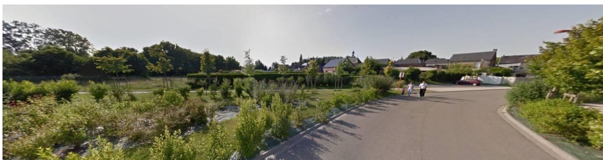
vue 2 : depuis la voie d'accès à la résidence des Tilleuls
