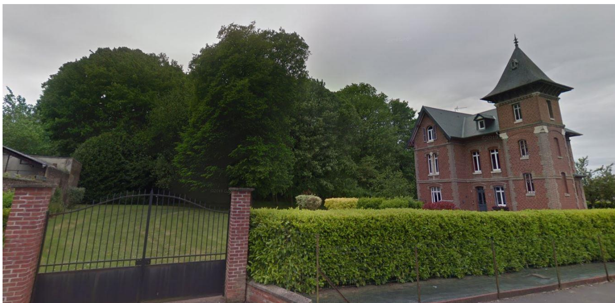
vue 4 : depuis la rue Curie
