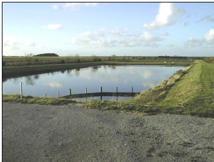
Le lagunage naturel de Bourseville avec au premier plan la 1ere lagune et la paroi siphonide
