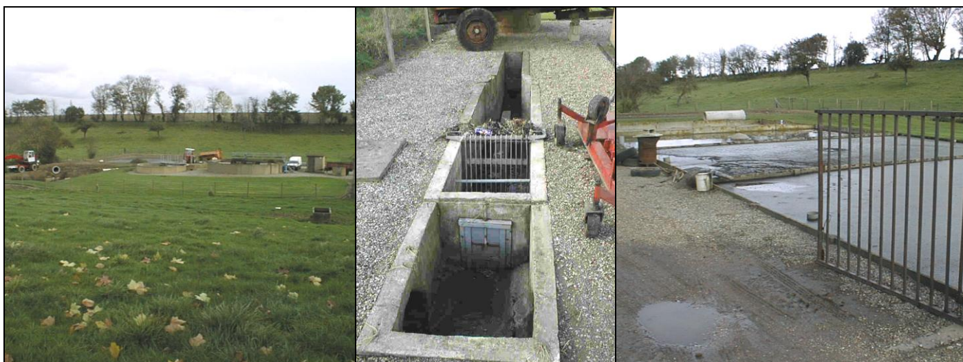
La station d'épuration de Chépy
