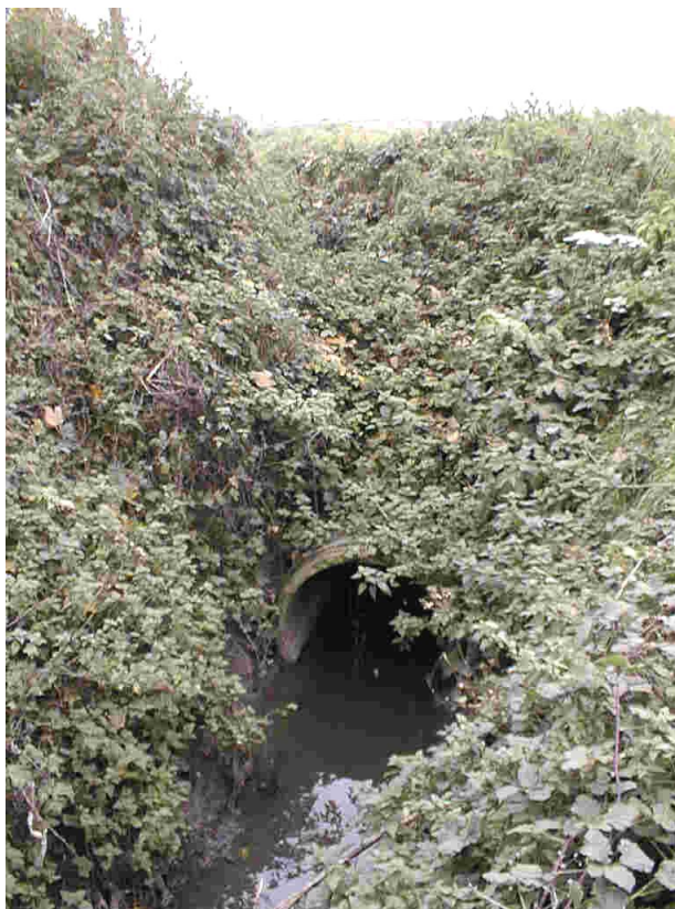
Photo 1 : L'exutoire du réseau pluvial de Nibas \phi 1 000
