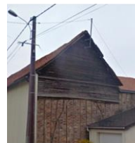
« Essentage » protection du pignon en tuile, en bois ou en ardoise.
