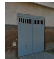
7 Porte « charretière » composée de deux grandes portes en bois, redivisées en partie haute à claire voie + petite porte en partie basse.
