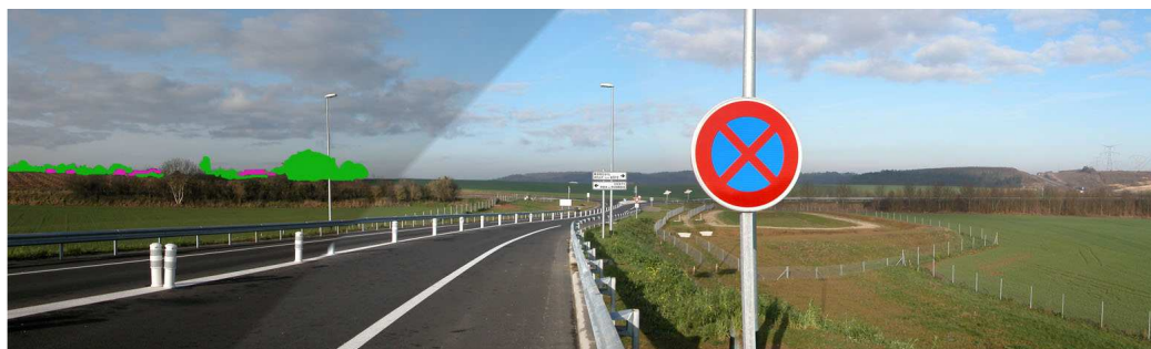
Vue depuis la sortie du diffuseur ; la petite portion du profil Est est très végétalisée depuis ce point de vue
