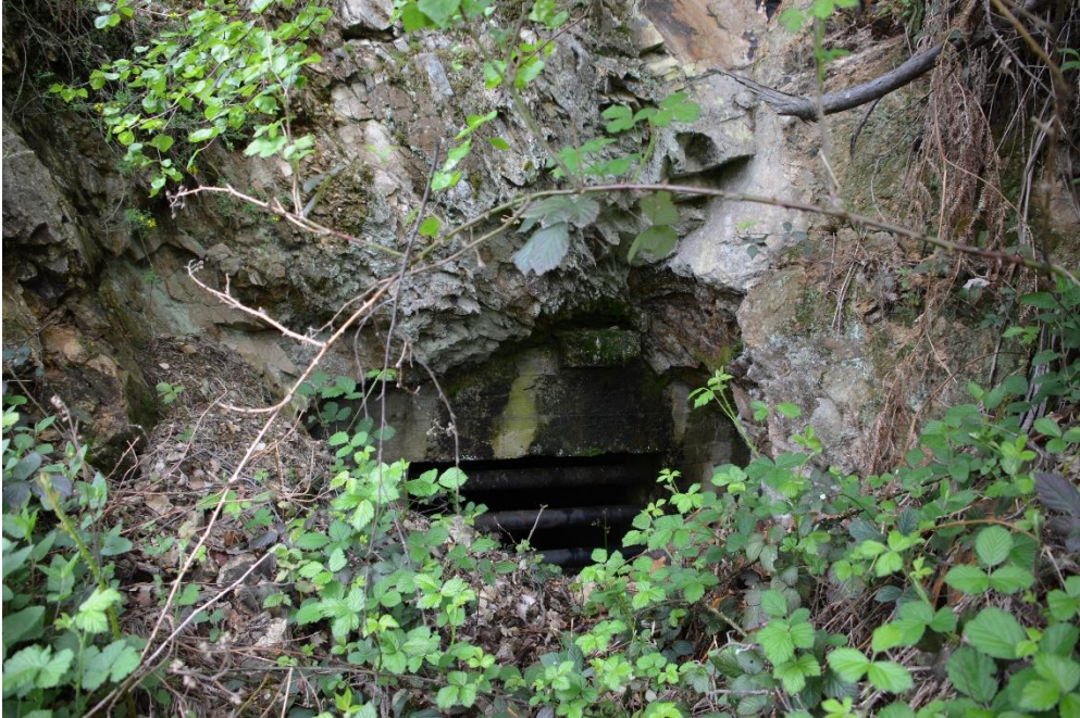
Entrée de la cavité du Chatelard le long de la route D182 (photo 160525_315 Luc Laurent)
