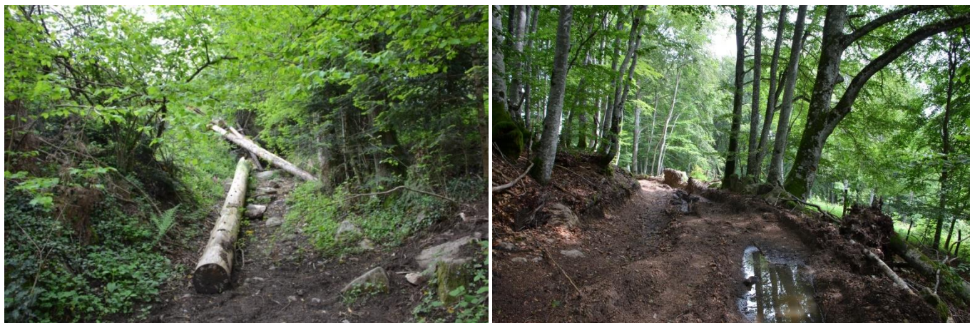
bords de chemins anciens bouchés ou endommagés à La Guillermie à la Pierre d'Argent (160526_492) et à Saint-Nicolas-des-Biefs au Mouzy (160620_66)
