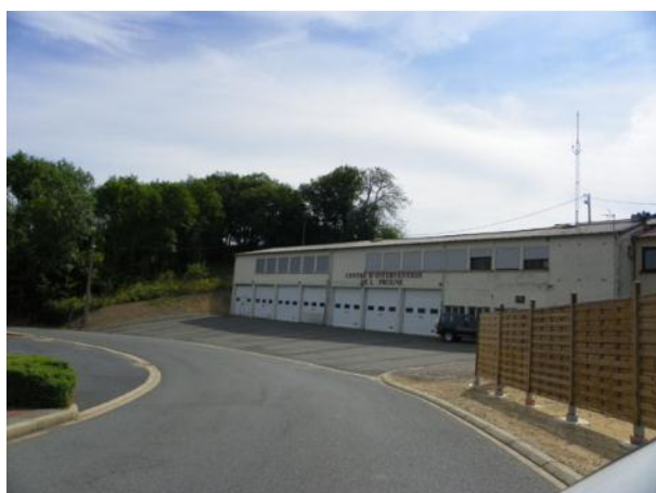
Caserne de pompiers à Laprugne
