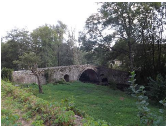
Pont du Moulin Chavan à Arronnes
