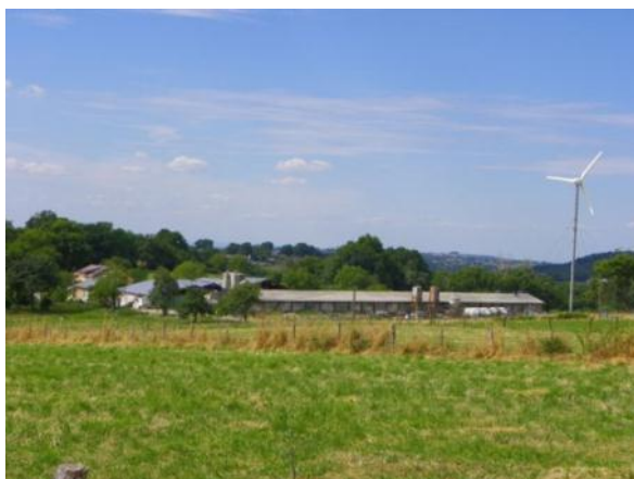
Ensemble bâti agricole de taille importante à Arronnes
