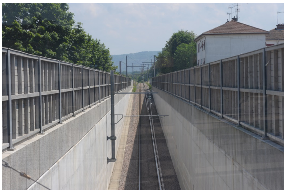
Exemples d'écrans acoustiques à Bourg en Bresse
