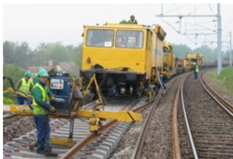
Longs Rails soudés sur traverses béton
