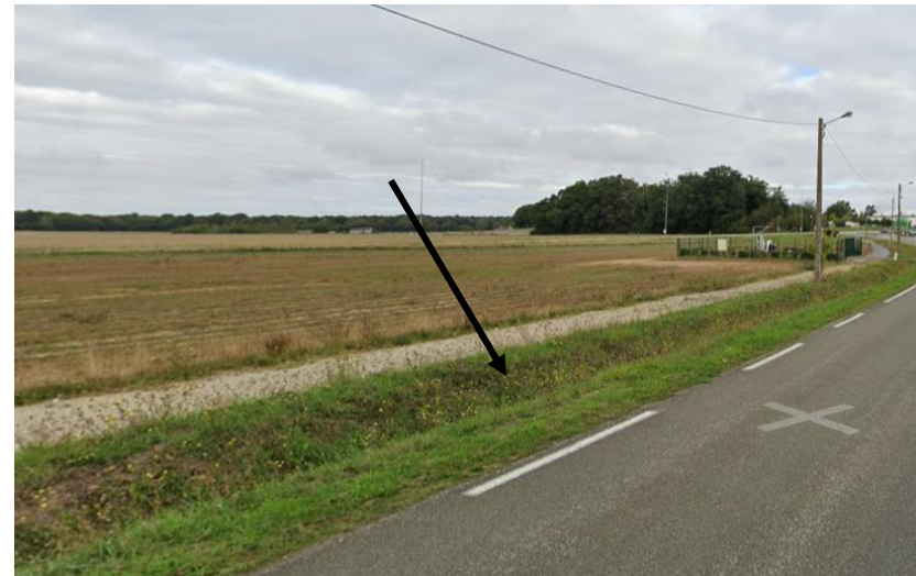
Fossé de drainage
